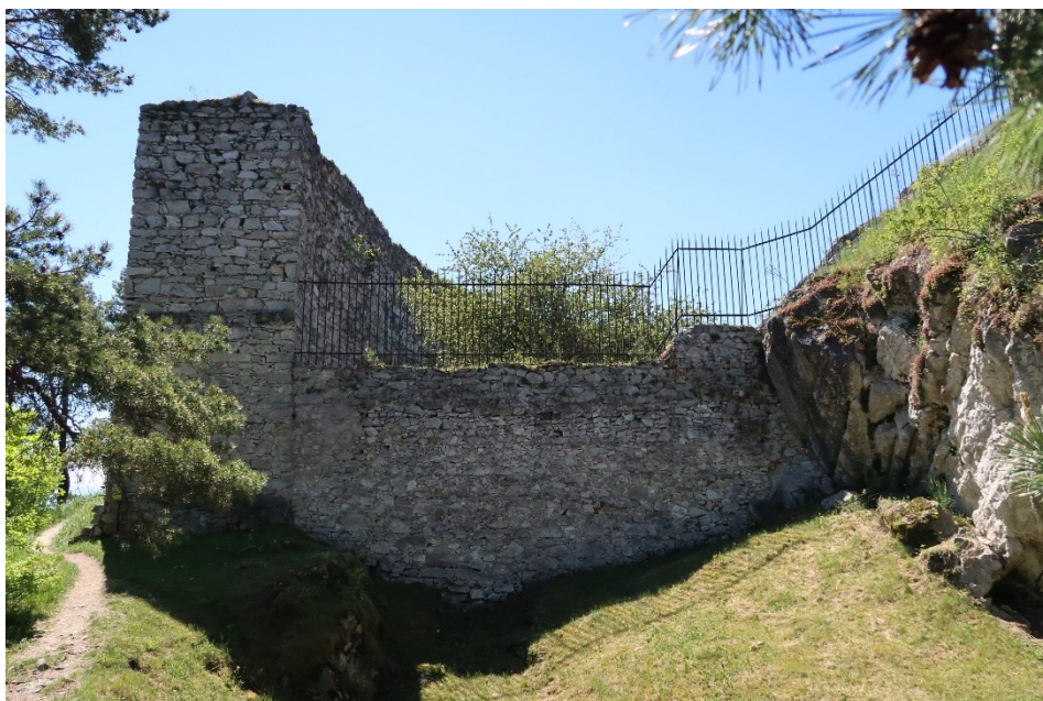
35. Dělostřelecké opevnění hradu Rabí – provizorní zakončení jihovýchodní hradby
