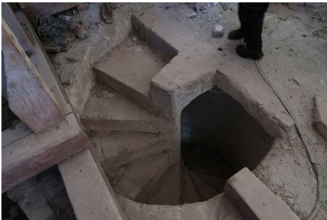
16. Ústí šnekového schodiště do krovu kostela
