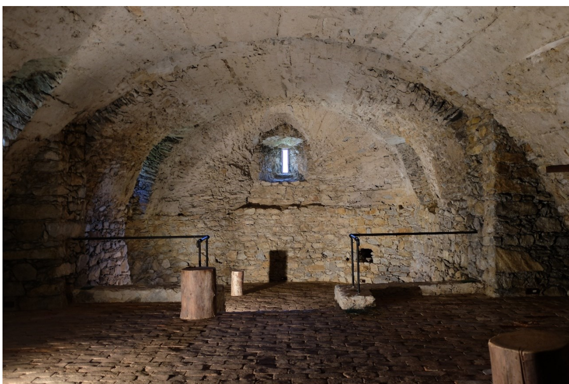
17. Prostor krypty pod kostelem, pohled směrem na východ
