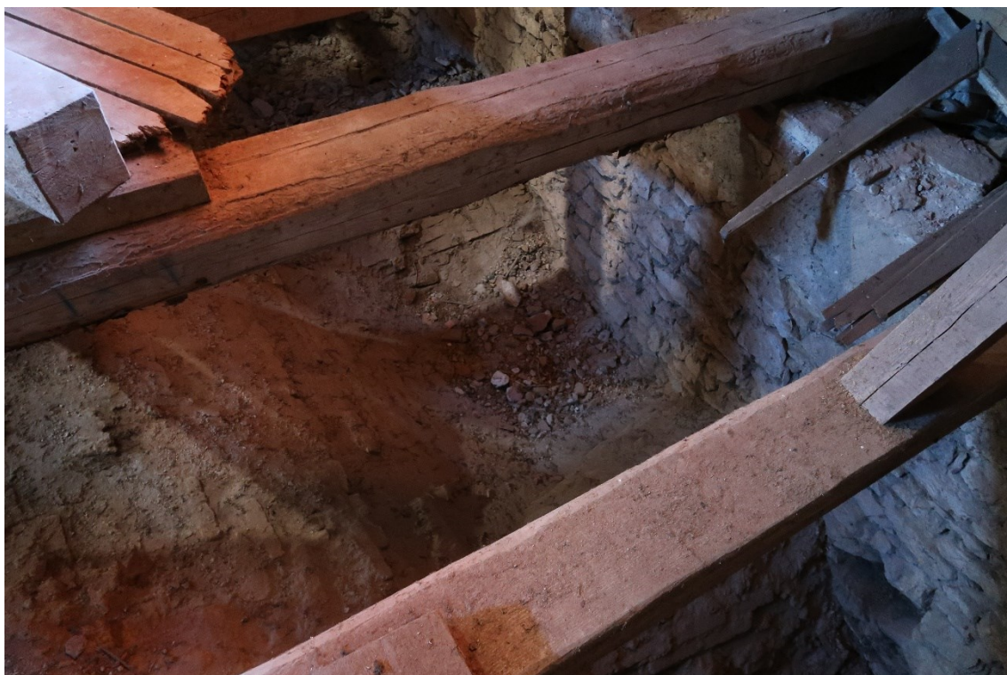
21. Pozůstatky klenebního zásypu nad prostorem lodi u severní zdi
