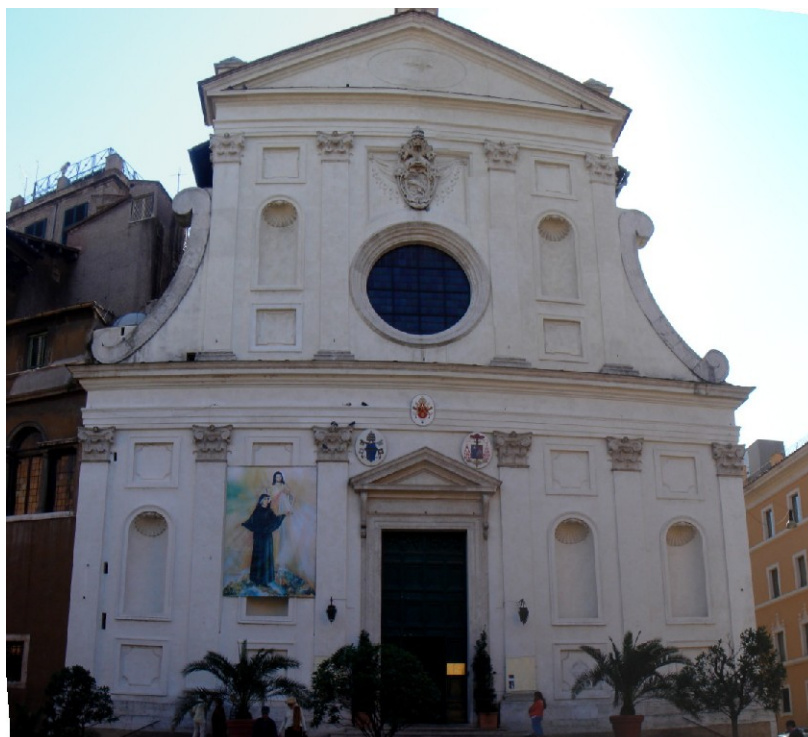
13. Řím, kostel S. Spirito in Sassia, 1590, průčelí.
