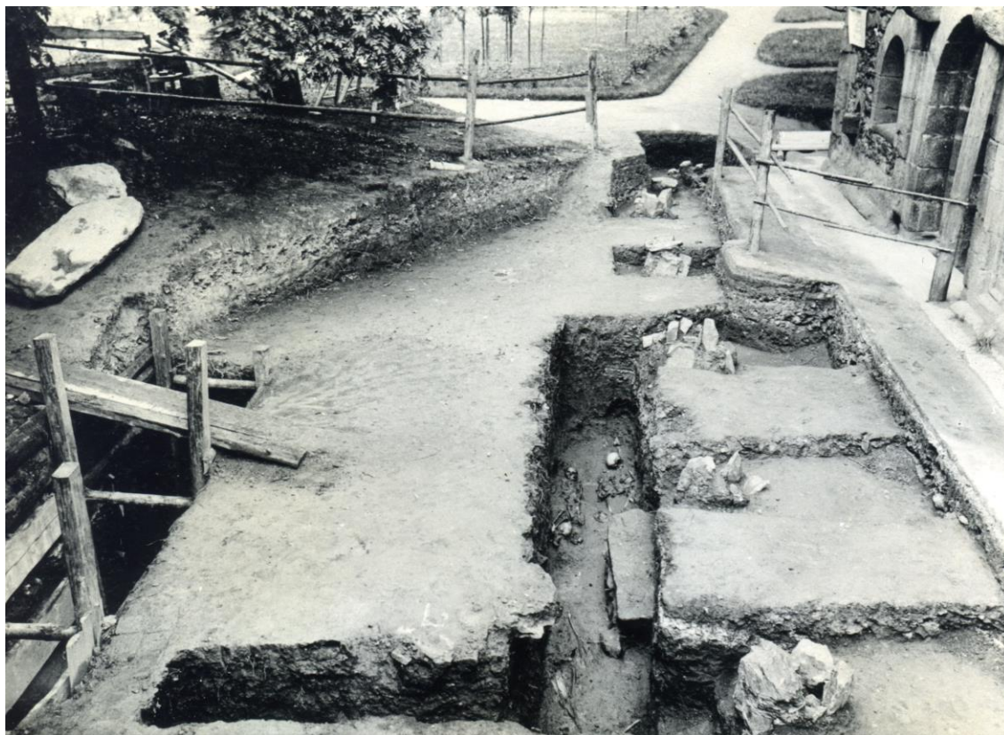
Obr. 55: Sondáž v prostoru jižně od hradní kaple, rok 1911 (foto z pozůstalosti A. Hejny, ARUP).
