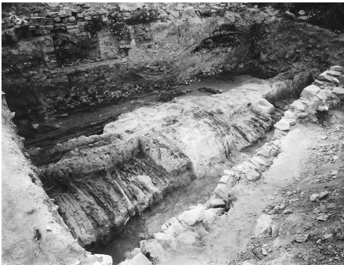
Obr. 61: Cheb, výzkum A. Hejny roku 1963. Dřevěná vnitřní konstrukce raně středověké hradby. ARUP, pozůstalost A. Hejny.
