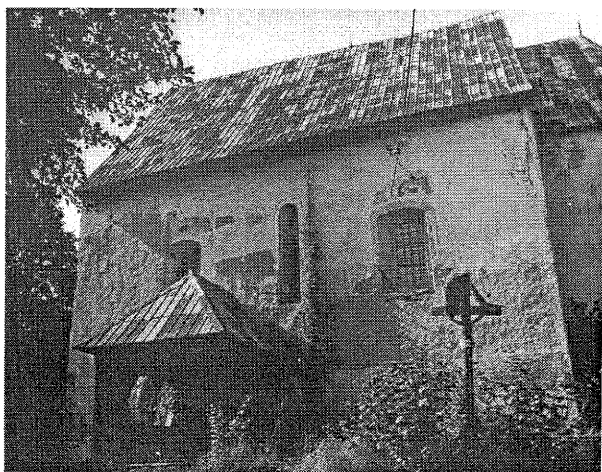
14. Rákoš, kostel Nejsvětější Trojice, polovina 13. století, pohled na jižní vstupní předsíň kostela.
