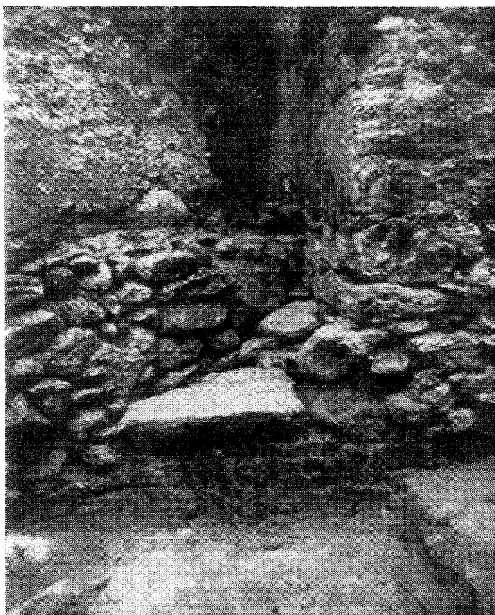
29. Rákoš, kostel Nejsvětější Trojice, detail základové patky apsidy v místě napojení sakristie na kostel.
