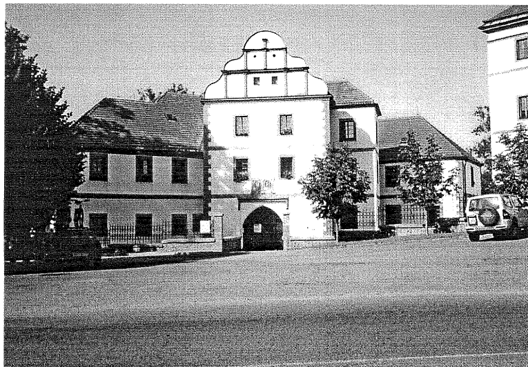
Obr. 1 – Lnářská tvrz, pohled od jihozápadu.
