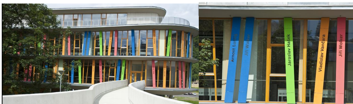
Obr. č. 12 – Charakteristická architektura knihovny (Pešek, 2012)
