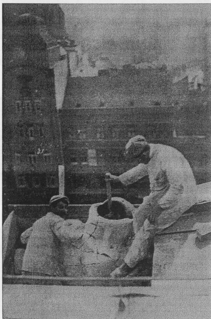
85.-86. Fotografie z průběhu prací na fasádě paláce Koruna, 1913.
