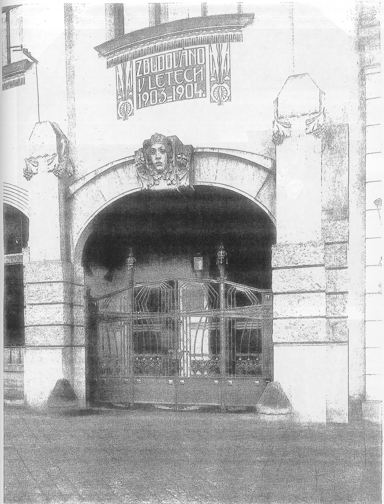
50. Výzdoba portálu průjezdu, Okresní dům v Hradci Králové, 1903-04.
