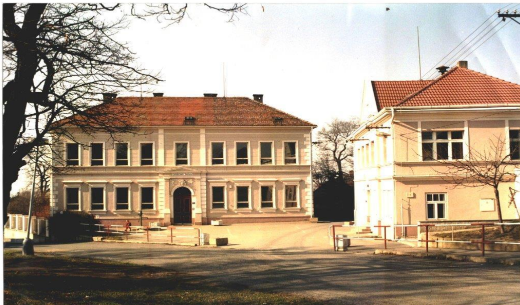
Obrázek č. 1: ZŠ Stoliňská stará budova
