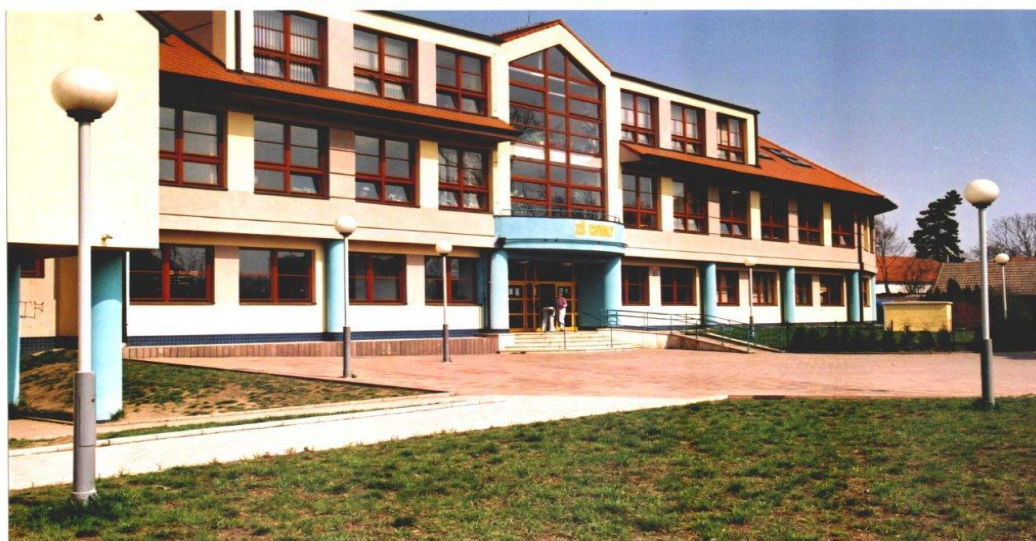
Obrázek č. 2: ZŠ Stoliňská nová budova
