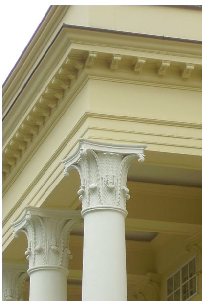
62) Kostelec nad Orlicí, zahradní průčelí – detail (vlastní fotografie)
