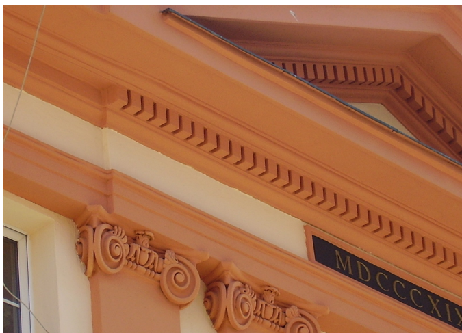
51) Dům č.p. 12 v Křížové ulici v Děčíně - detail (vlastní fotografie)
