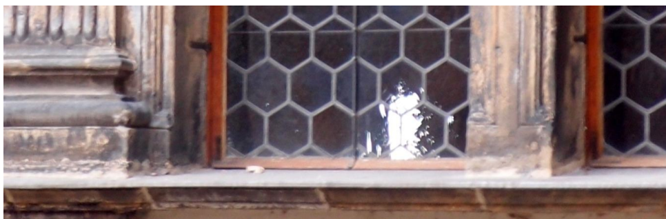
[58] Okna severního průčelí Vladislavského sálu, kolem 1493, pískovec, Pražský hrad, Praha, detail pravouhlého zalomení profilů.
