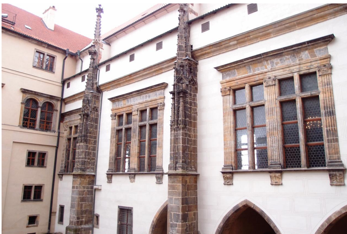
[54] Severní průčelí Vladislavského sálu, mezi 1493 – 1500, Pražský hrad, Praha.
