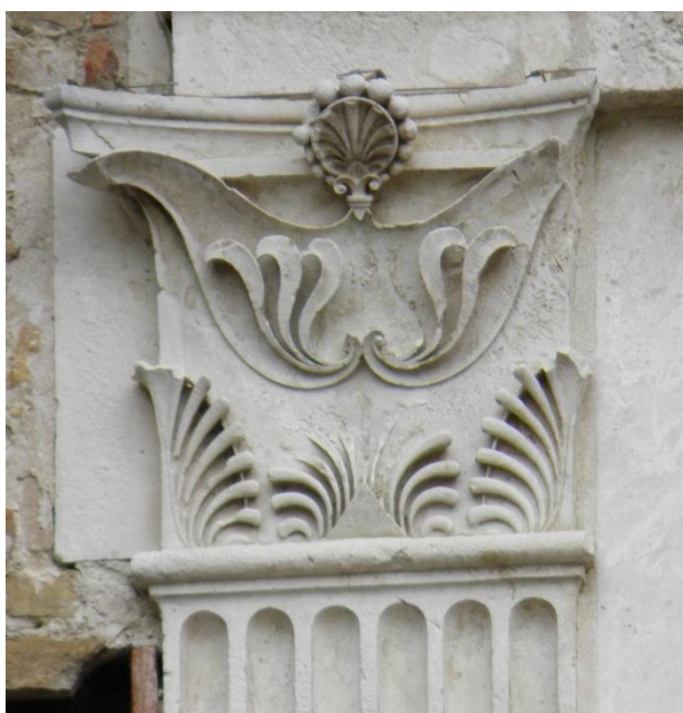
[47] Edikulové okno, kolem 1474, průčelí Palazza Ducale, Urbino, detail hlavice.
