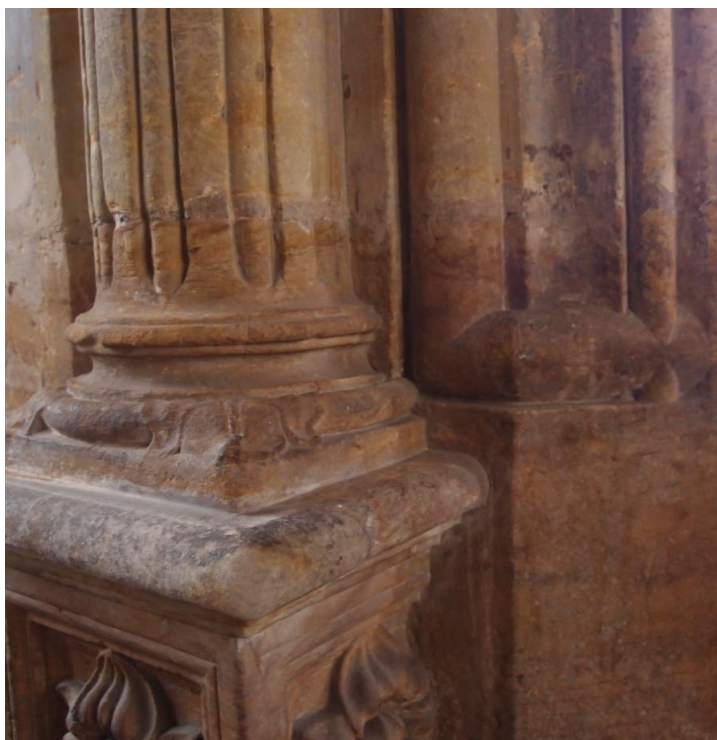
[15] Portál v Ludvíkově křídle, do 1508, Pražský hrad, Praha, detail pravouhlého zalomení profilů a křížení prutů.
