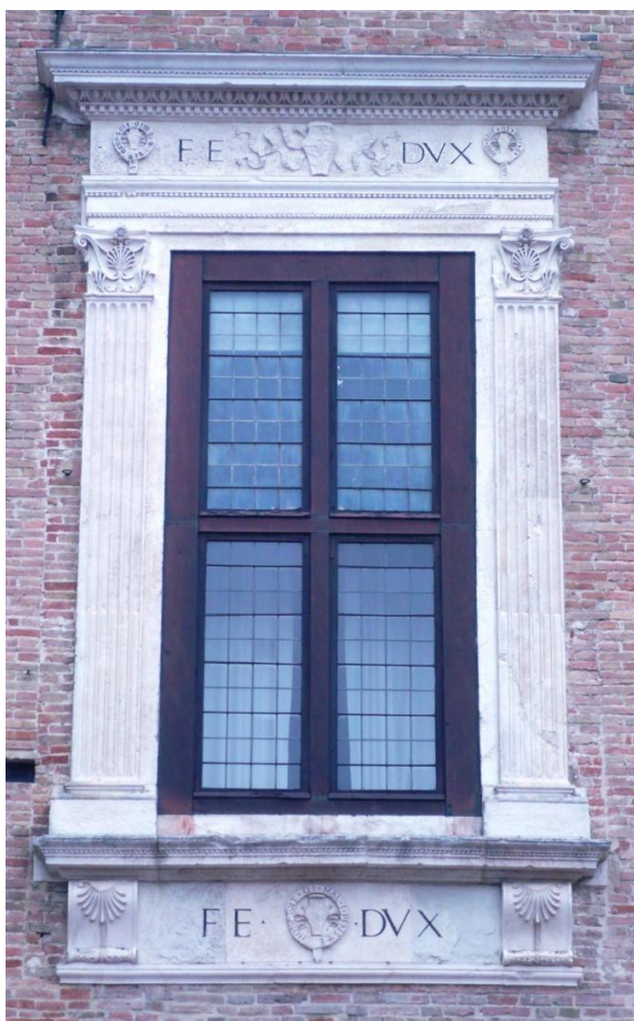
[44] Edikulové okno, kolem 1474, průčelí Palazza Ducale, Urbino, celkový pohled.
