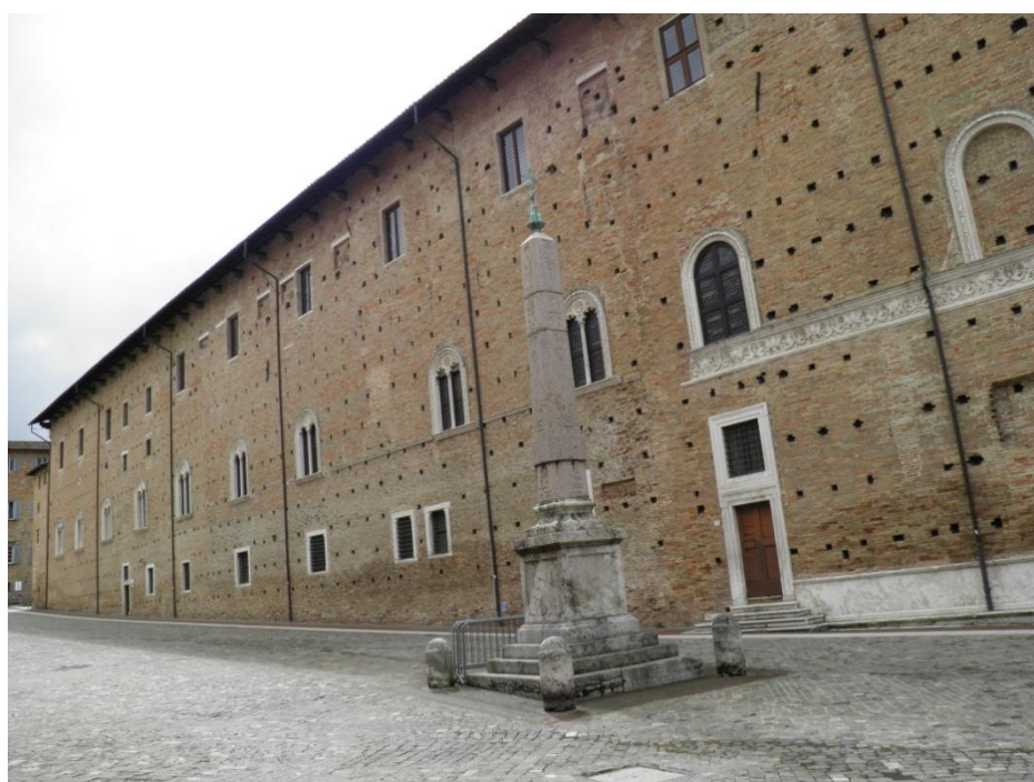
[35] Palazzetto della Jole, 50. léta 15. století, Urbino, pohled na průčelí.
