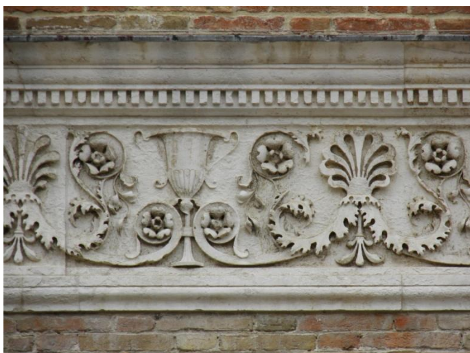
[46] Průčelí Palazza Ducale, kolem 1474, Urbino, detail podokenní římsy.
