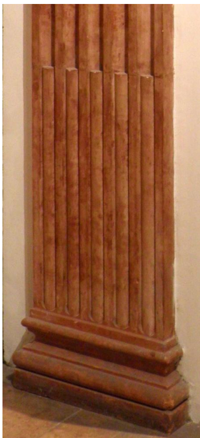
[51] Rekonstrukce pilastru, poslední čtvrtina 15. století, Budínský hrad, Budapešť, detail píšťal vložených do kanel.
