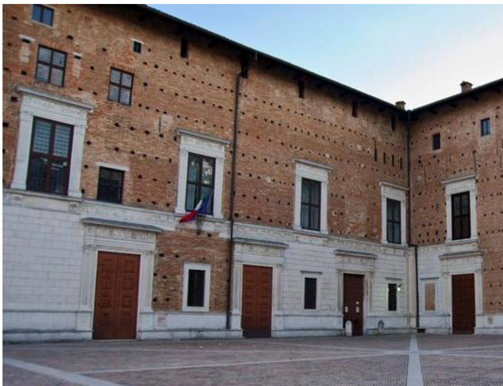
[43] Průčelí Palazza Ducale, kolem 1474, Urbino, pohled na částečně provedené obložení jižní fasády.
