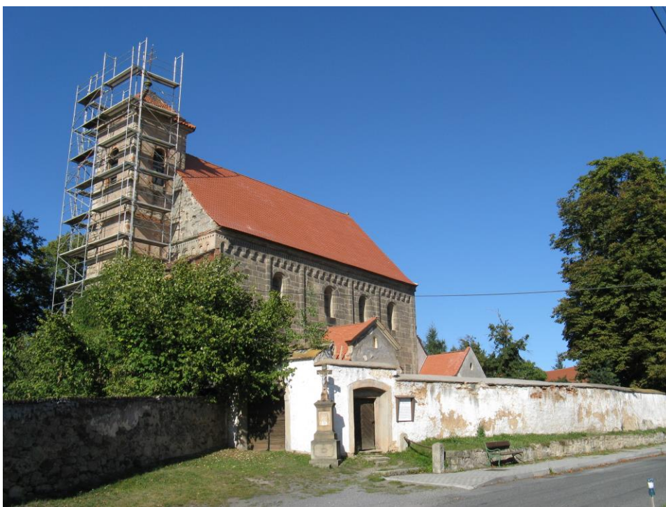
4. Potvorov , kostel sv. Mikuláše, oprava zvonové věže v roce 2008, pohled od jihozápadu
