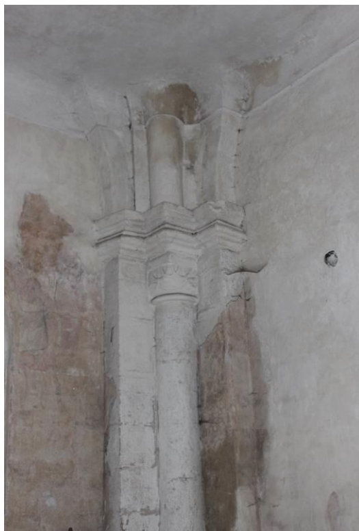
38. Potvorov , kostel sv. Mikuláše, křížový čtvrtpilíř s vloženým sloupkem, severozápadní roh tribuny
