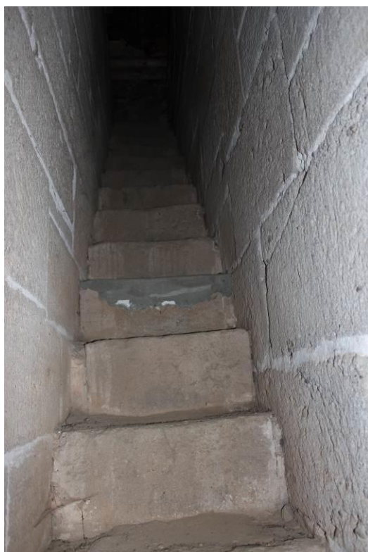
42. Potvorov , kostel sv. Mikuláše, schodiště v síle severní stěny ústící do podstřeší
