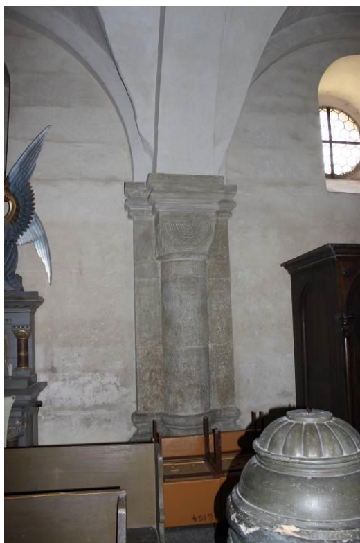
35. Potvorov , kostel sv. Mikuláše, přízední pilíř s předsazeným polosloupkem, západní stěna podkruchtí
