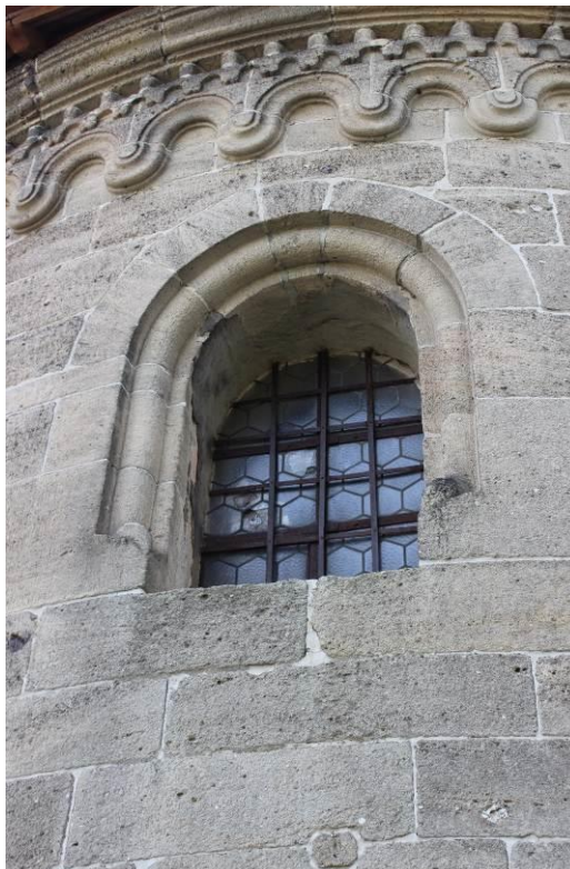
20. Potvorov , kostel sv. Mikuláše, okno, jižní část apsidy
