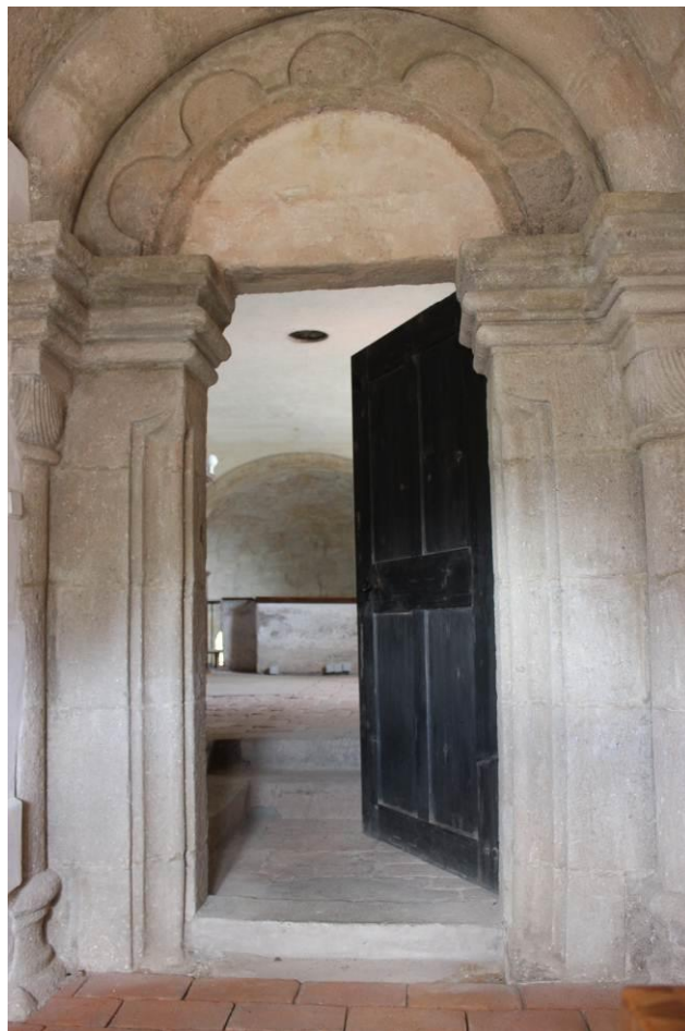
27. Potvorov , kostel sv. Mikuláše, portál v západním průčelí vedoucí na tribunu
