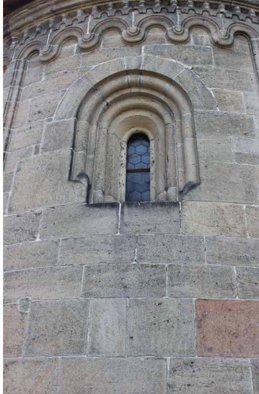
19. Potvorov , kostel sv. Mikuláše, okno s původním románským ostěním, osa apsidy
