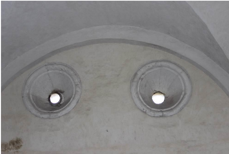
36. Potvorov , kostel sv. Mikuláše, okna, jižní stěna podkruchtí
