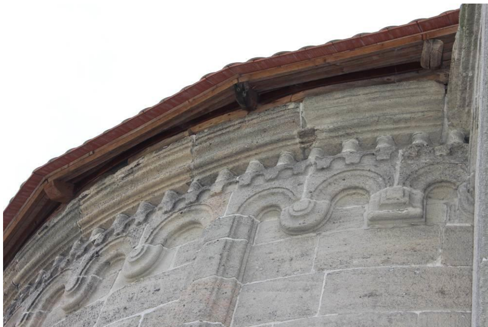
18. Potvorov , kostel sv. Mikuláše, obloučkový vlys s rovně ukončeným obloučkem, severní část apsidy
