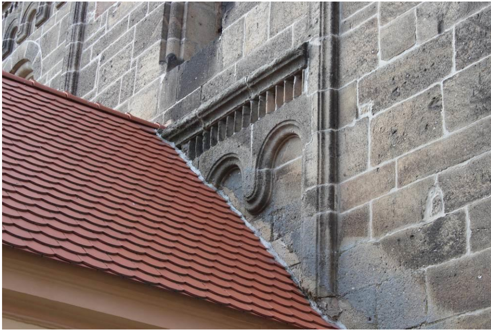
11. Potvorov , kostel sv. Mikuláše, obloučkový vlys nad vstupním portálem, jižní průčelí
