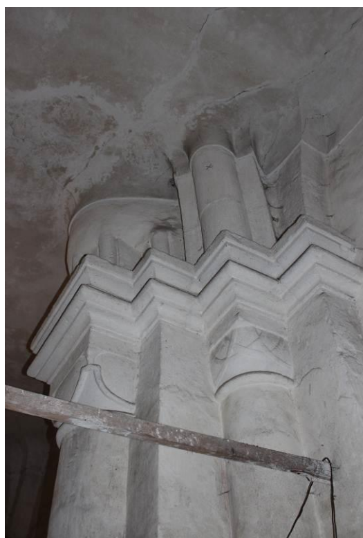
39. Potvorov , kostel sv. Mikuláše, svazkový polopilíř, detail, západní stěna tribuny
