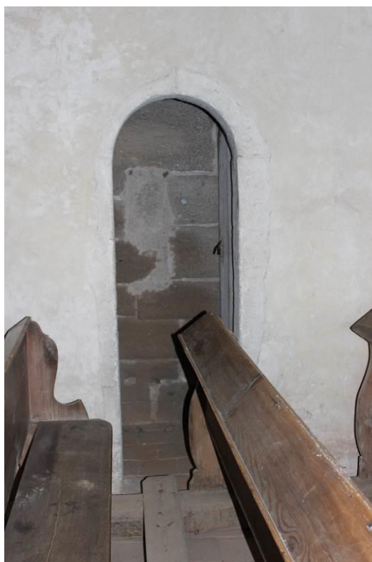
41. Potvorov , kostel sv. Mikuláše, vstup na schodiště v síle severní stěny, první patro tribuny
