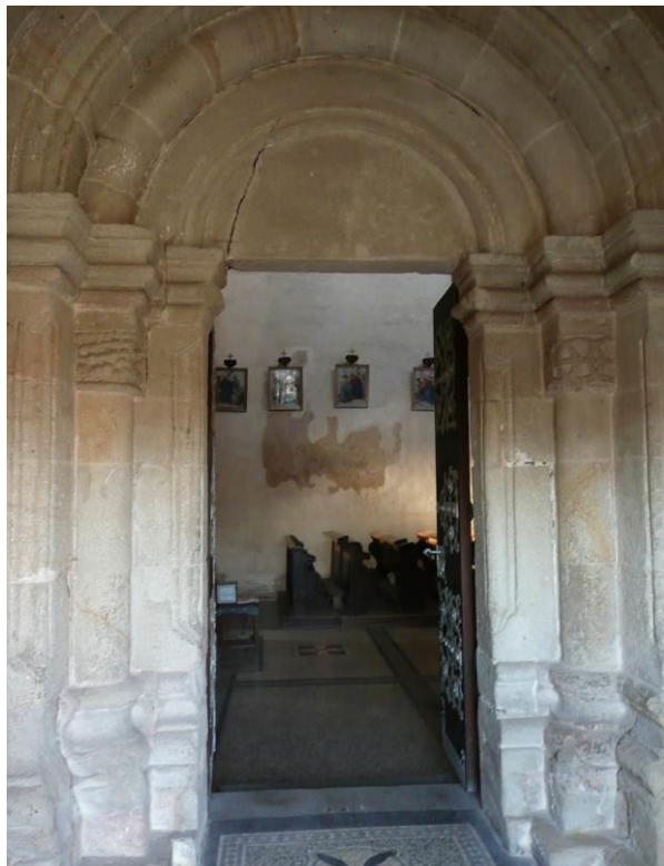
12. Potvorov , kostel sv. Mikuláše, ústupkový portál, hlavní vstup, jižní průčelí kostela
