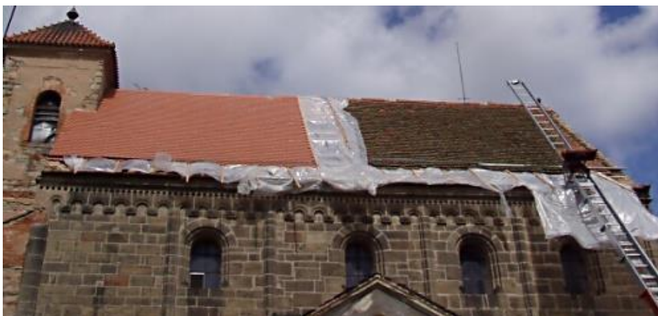
3. Potvorov , kostel sv. Mikuláše, rekonstrukce střechy kostela v roce 2008, pohled od jihu
