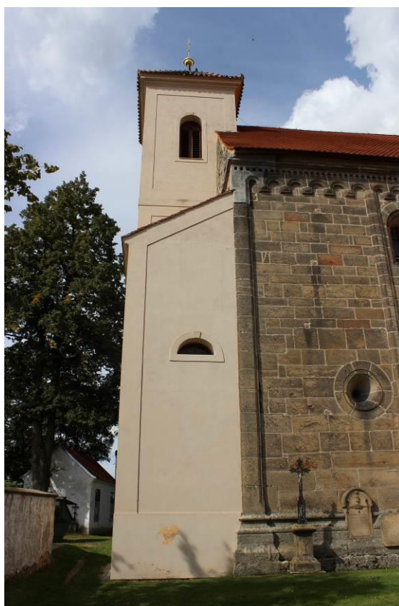
25. Potvorov , kostel sv. Mikuláše, schodišťový přístavek, pohled od jihu
