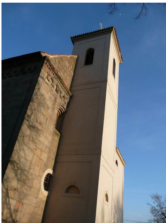
24. Potvorov , kostel sv. Mikuláše, pohled na věž a část západní stěny od severu
