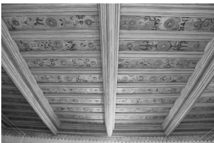
32. Strakonice, palác Bavorů, detail dřevěného stropu
