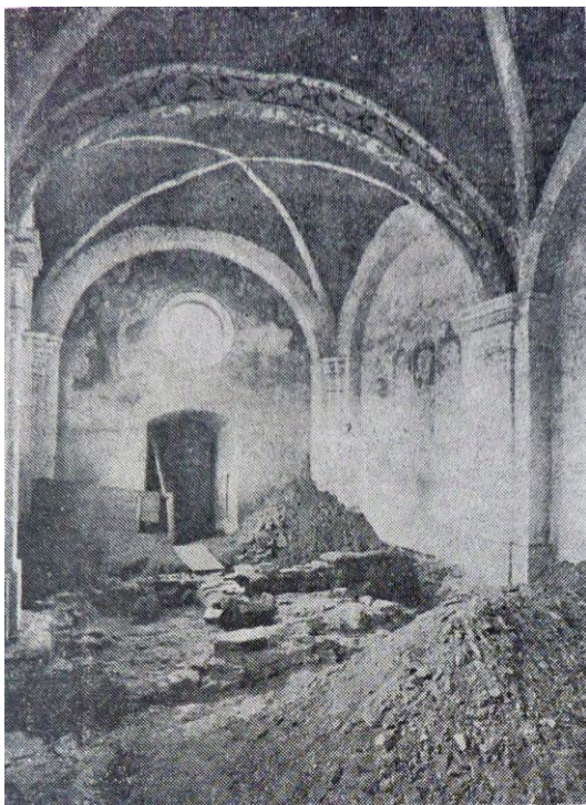
29. Strakonice , kapitulní síň, objekt pod podlažím, pohled z jihu
