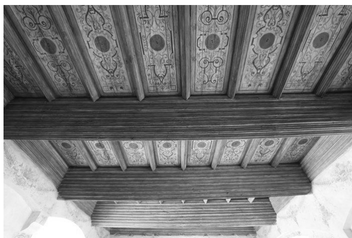
33. Strakonice, palác Bavorů, detail dřevěného stropu
