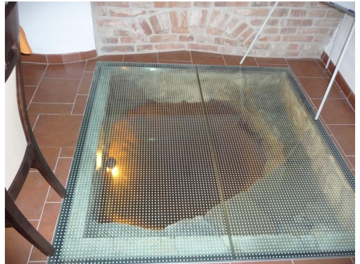
Příloha 51: Renovovaná rituální lázeň – zasklená v konferenční místnosti Hotelu Joseph Skalní 85/5 Třebíč.
