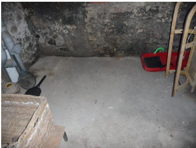
Příloha 47: Sklepení domu L. Pokorného 14/8 Třebíč. Toto je zabetonovaná část sklepení, právě zde se v 19. stol. mikve nacházela.
