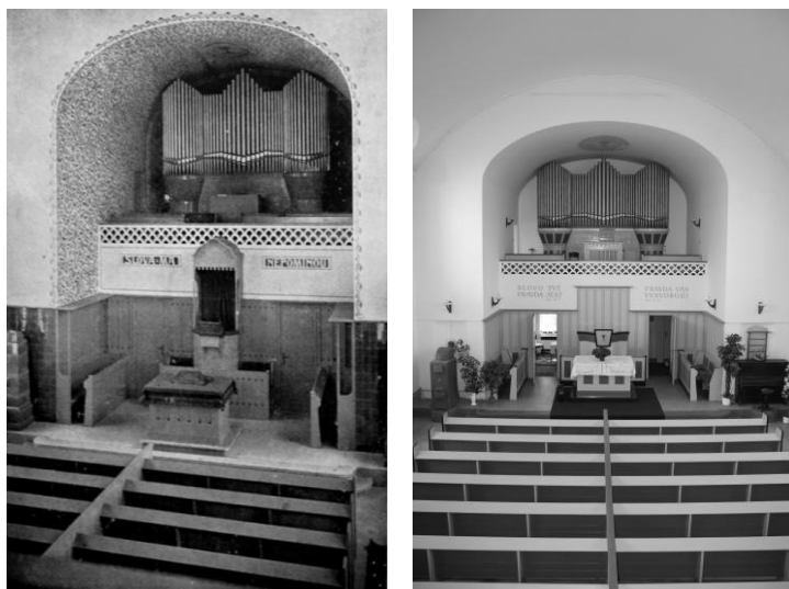
[96] Roudnice nad Labem, evangelický kostel, Otto Kuhlmann, 1908–1909, porovnání původního a současného stavu, interiér
