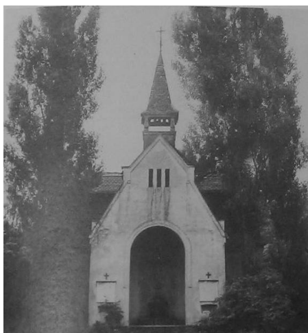
[49] Praha, hřbitovní kaple psychiatrické léčebny v Bohnicích, Václav Roštlapil ?, 1909
