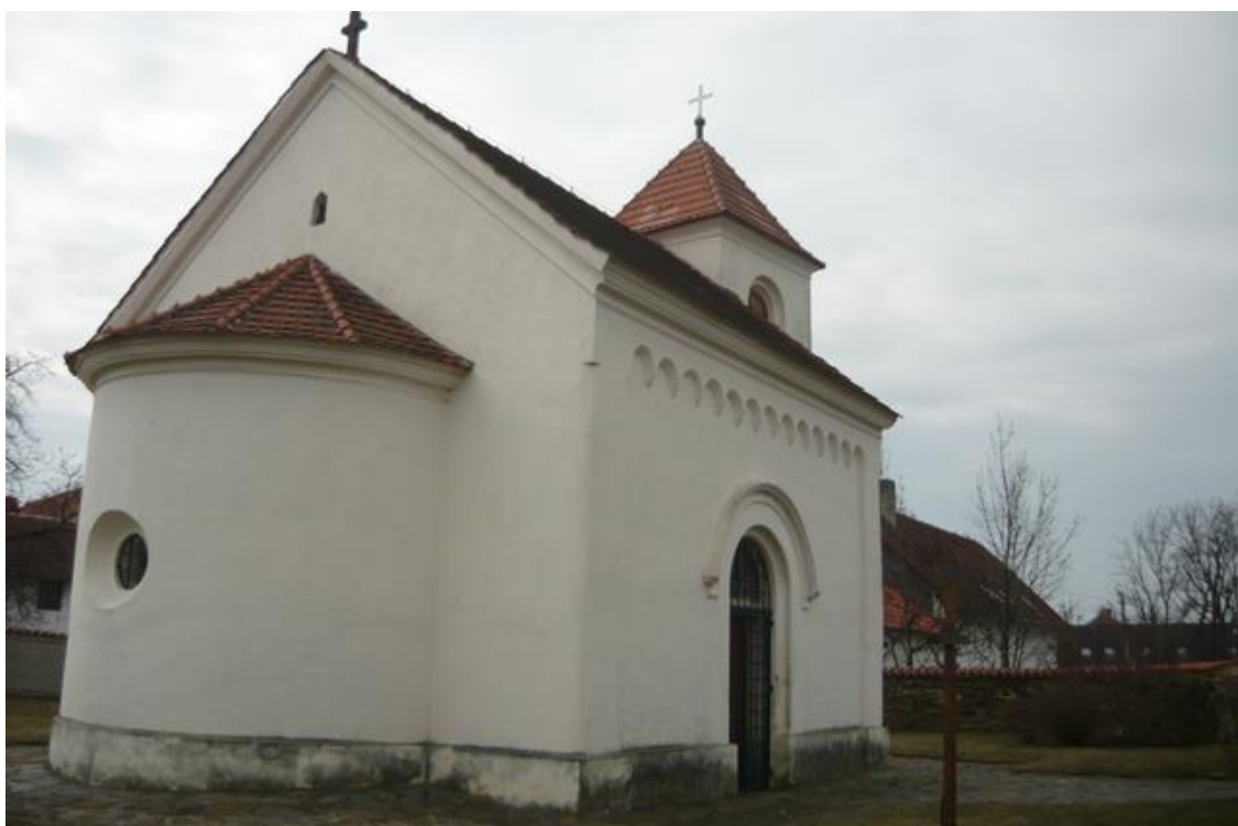
14. Kostel sv. Martina v Lipanech, 1863, pohled od severozápadu
