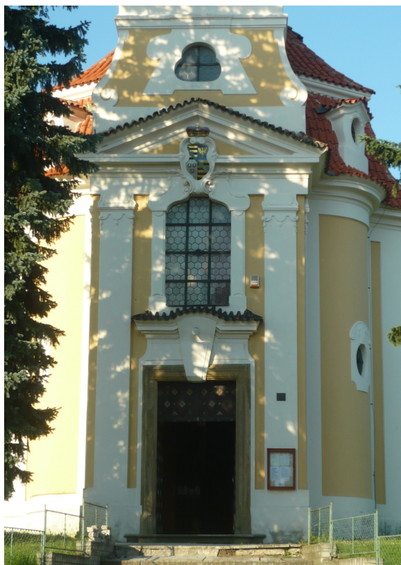
3. Rudná – Hořelice. Kostel Stětí sv. Jana Křtitele. Průčelí.
