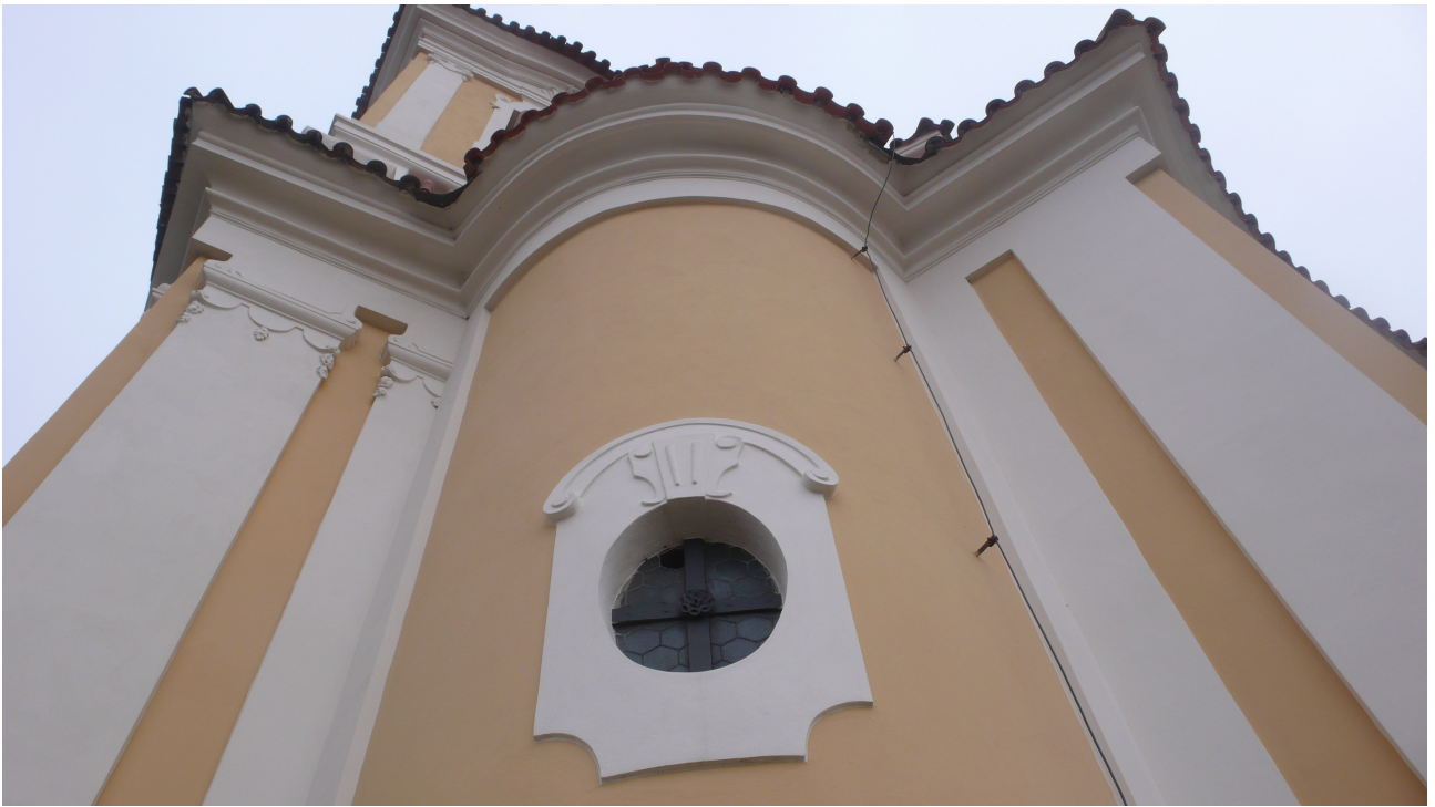
13. Rudná – Hořelice. Kostel Stětí sv. Jana Křtitele. Okno schodištního výstupku.
