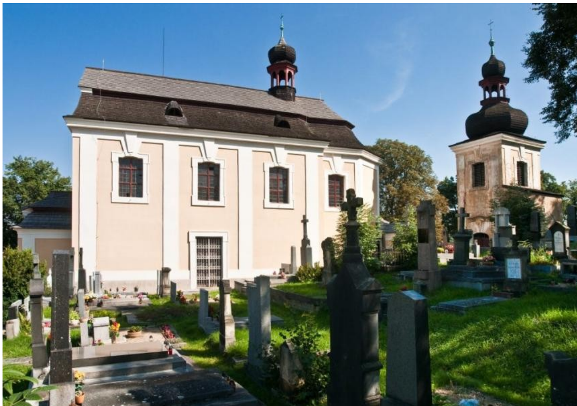
44. Liběchov, kostel sv. Havla. Detail průčelí.
