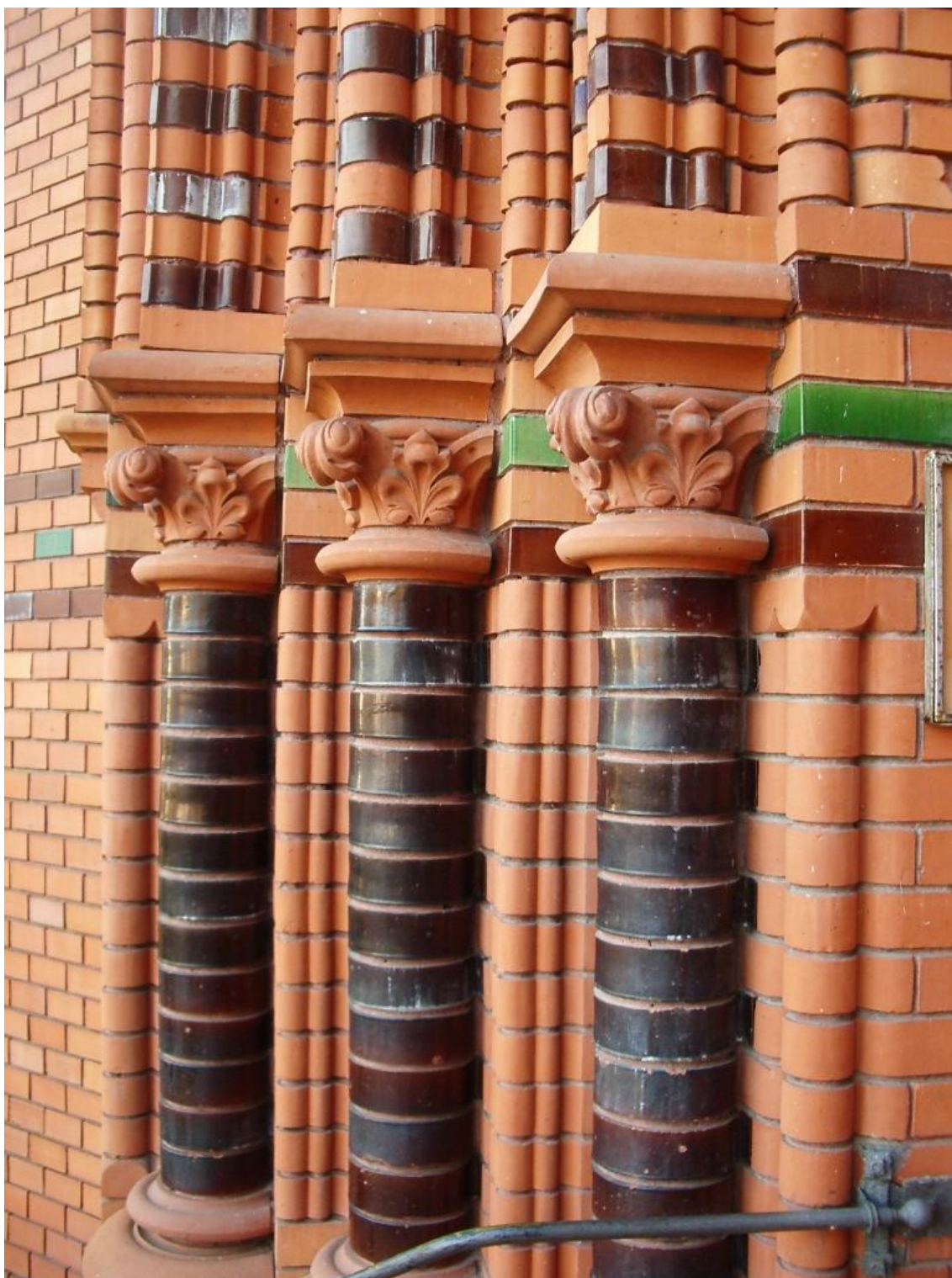
90. Poštorná, kostel Navštívení Panny Marie, sloupky potrálu
