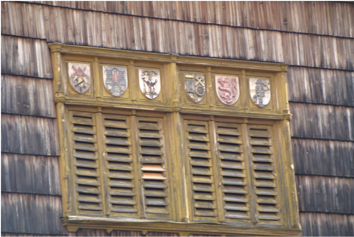
11. Rakovník, zvonice kostela sv. Bartoloměje, detail okna v západní stěně
