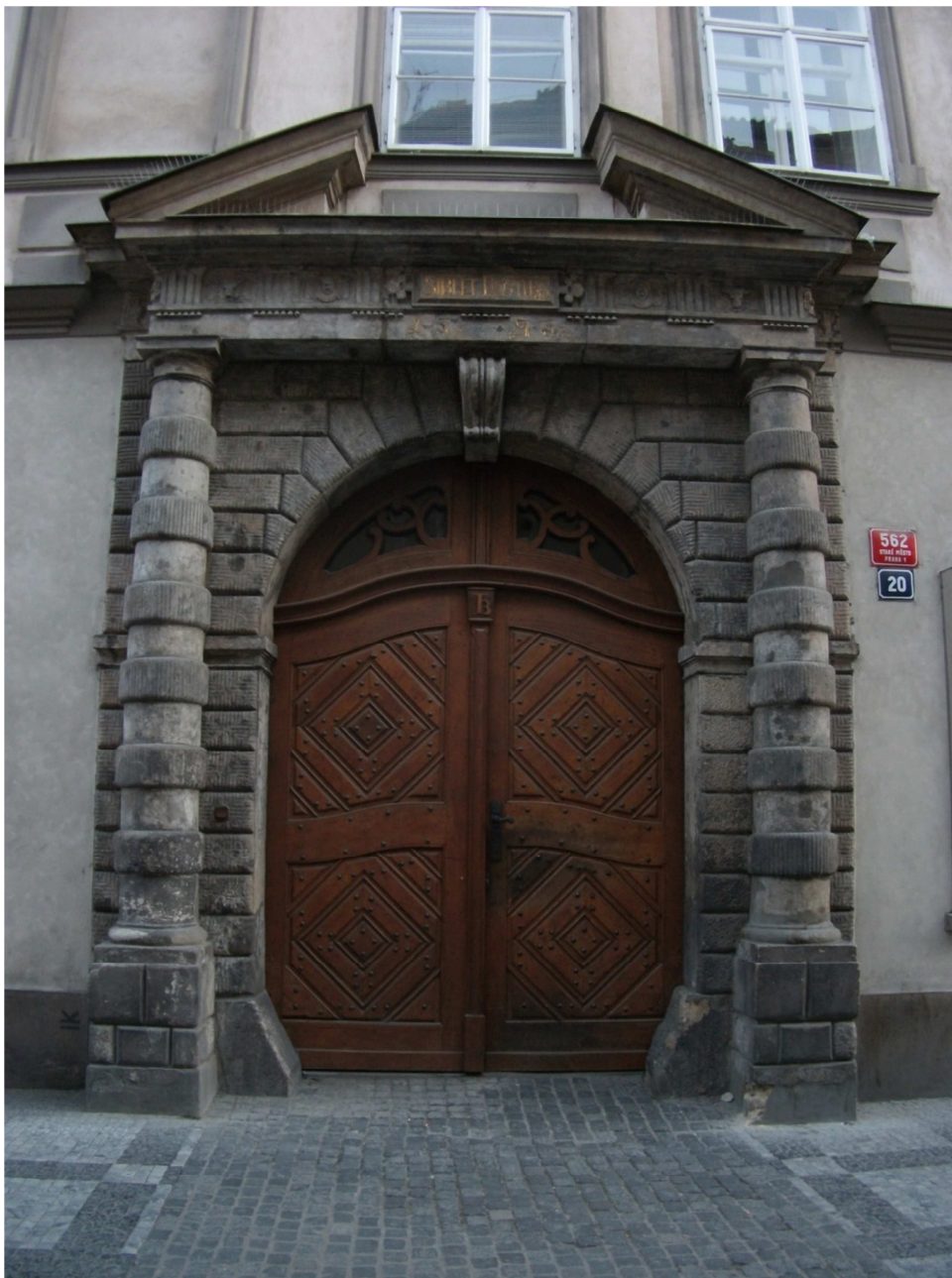
17. Praha, portál Dům Buquoyský, 1628, čelní pohled
