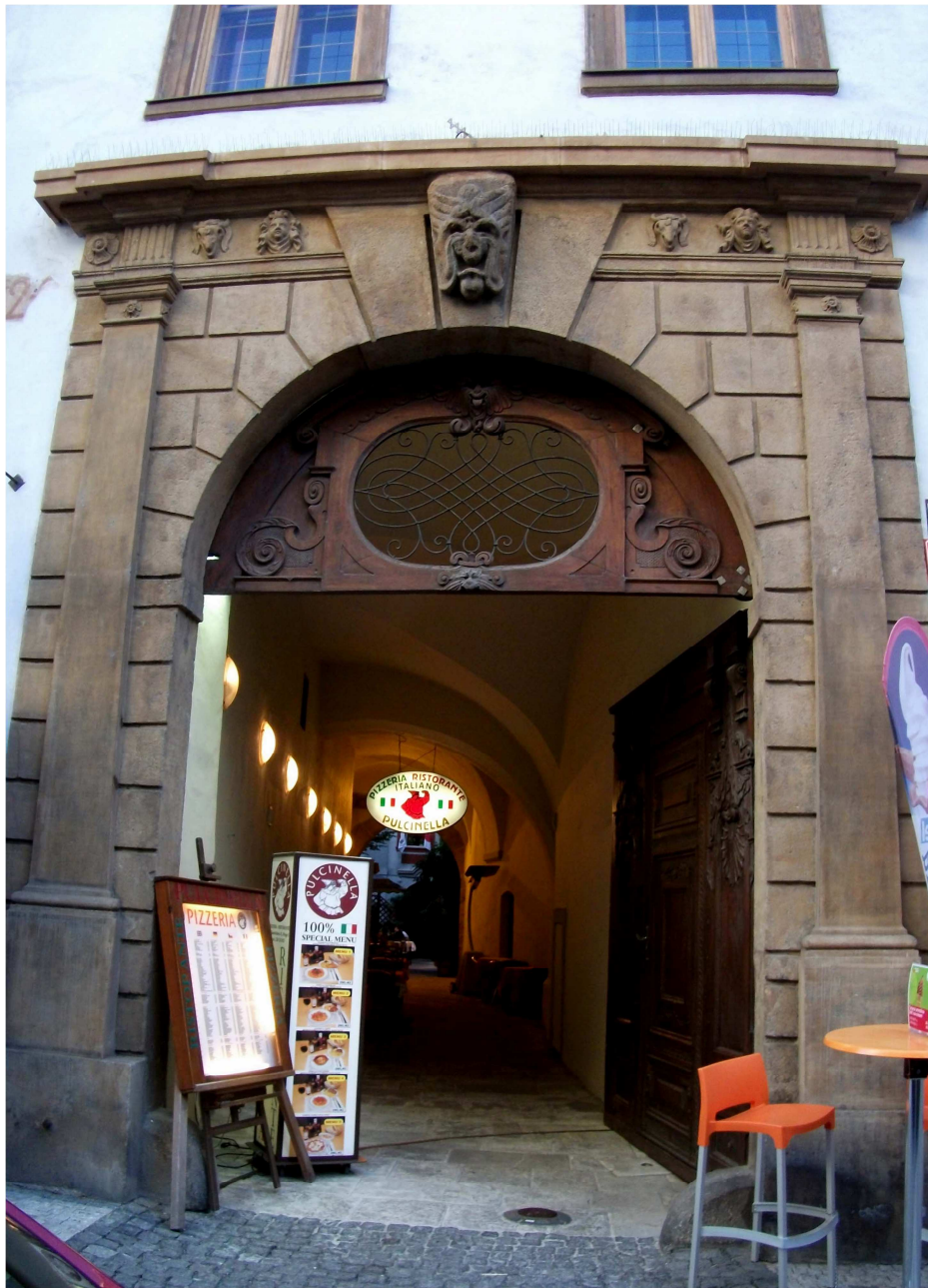
14. Praha, portál U pěti korun, 1615, čelní pohled
