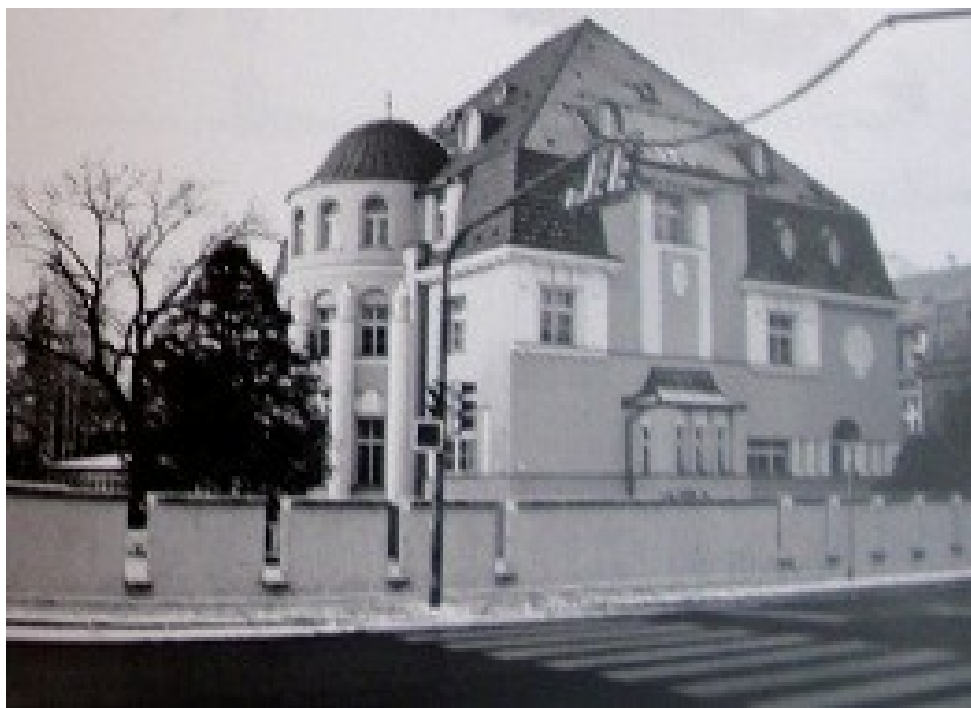
25 Liberec, Jablonecká ulice, vila č. p. 7-V, z r. 1911.
