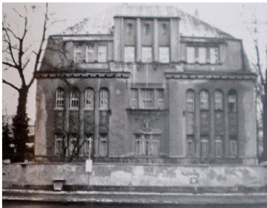
23 Liberec, Jablonecká ulice, vila č. p. 91–V, z r. 1911.
