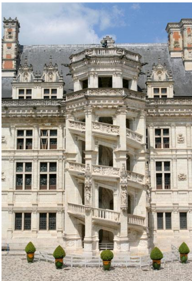
29. Francie, zámek Blois, křídlo Františka I. , spirálovité renesanční schodiště ve věži
