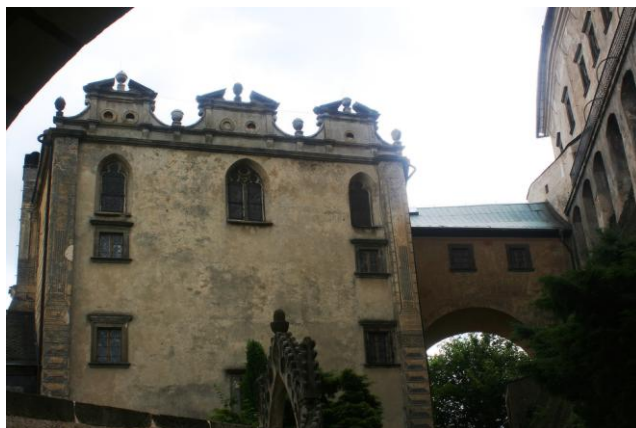
36. Frýdlant, Křídlo zámecké kaple propojené prampouchem k Hornímu hradu
