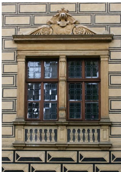
36. Frýdlant, Dolní zámek, sdružená okna s naznačenými kuželky ve sgrafitové technice, Kastelánské křídlo
