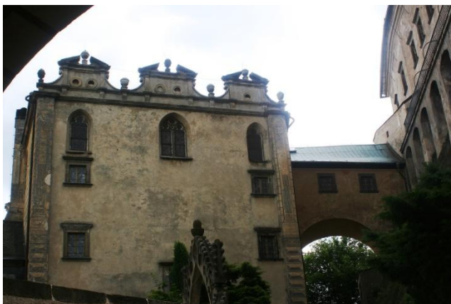
37. Frýdlant, Křídlo zámecké kaple propojené prampouchem k Hornímu hradu
