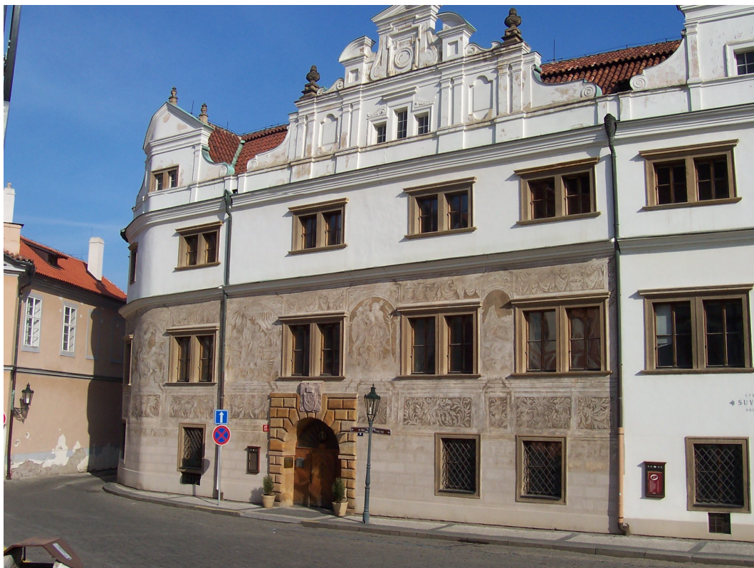
1. Průčelí Martinického paláce směrem k Hradčanskému náměstí
