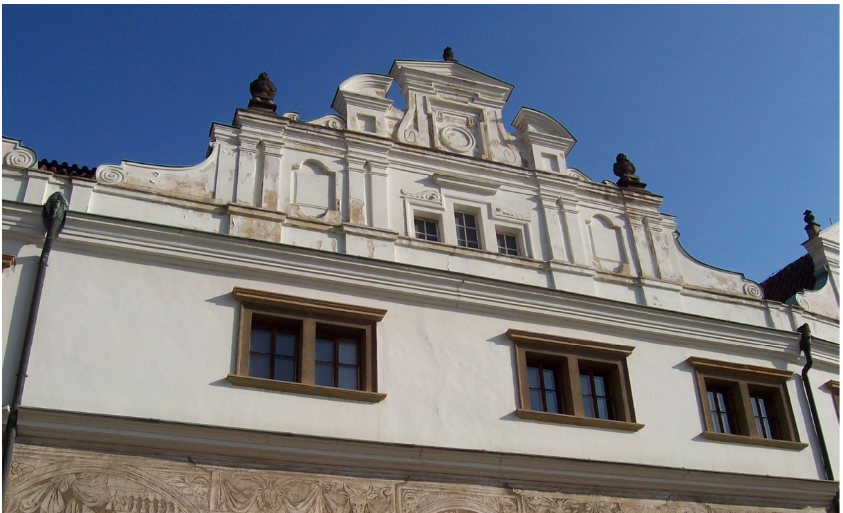
10. Prostřední štít jižního průčelí jižního křídla
