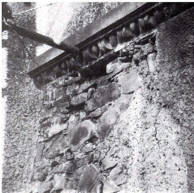
44. Tovačov. Zámek. Římsa zdobená vejcovcem, zasazená do kamenného zdiva v průčelí vysoké věže
