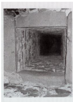
23. Tovačov, východní rondel zámku, detail transportního otvoru v klenbě
