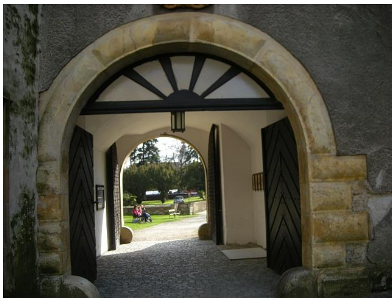
36. Tovačov. Zámek. Nádvoří, bosovaný portál vstupní věže, 1492
