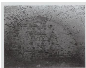
22. Tovačov, východní rondel zámku, interiér s valenou klenbou a transportním otvorem
