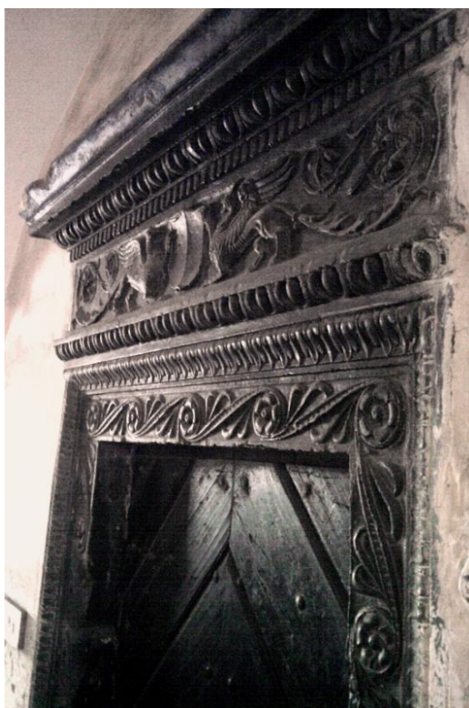
61. Tovačov. Dům v ulici:Förchgottova čp. 8. portál: „Tovačovských paní“– předsíň, původně na průčelí domu, 1490–1492
