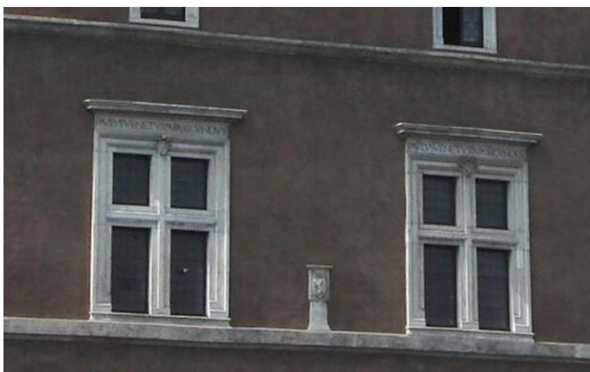
45. Řím. Palazzo Venezia. Výřez oken paláce Venezia v Římě. Jednoosá okna s vlysem a římsou
