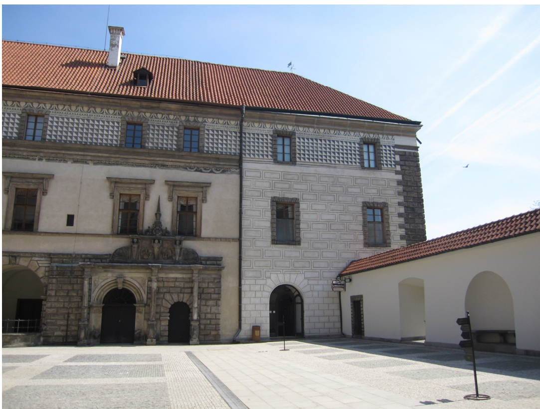
18. Nelahozeves, zámek, jihovýchodní bastion z nádvoří
