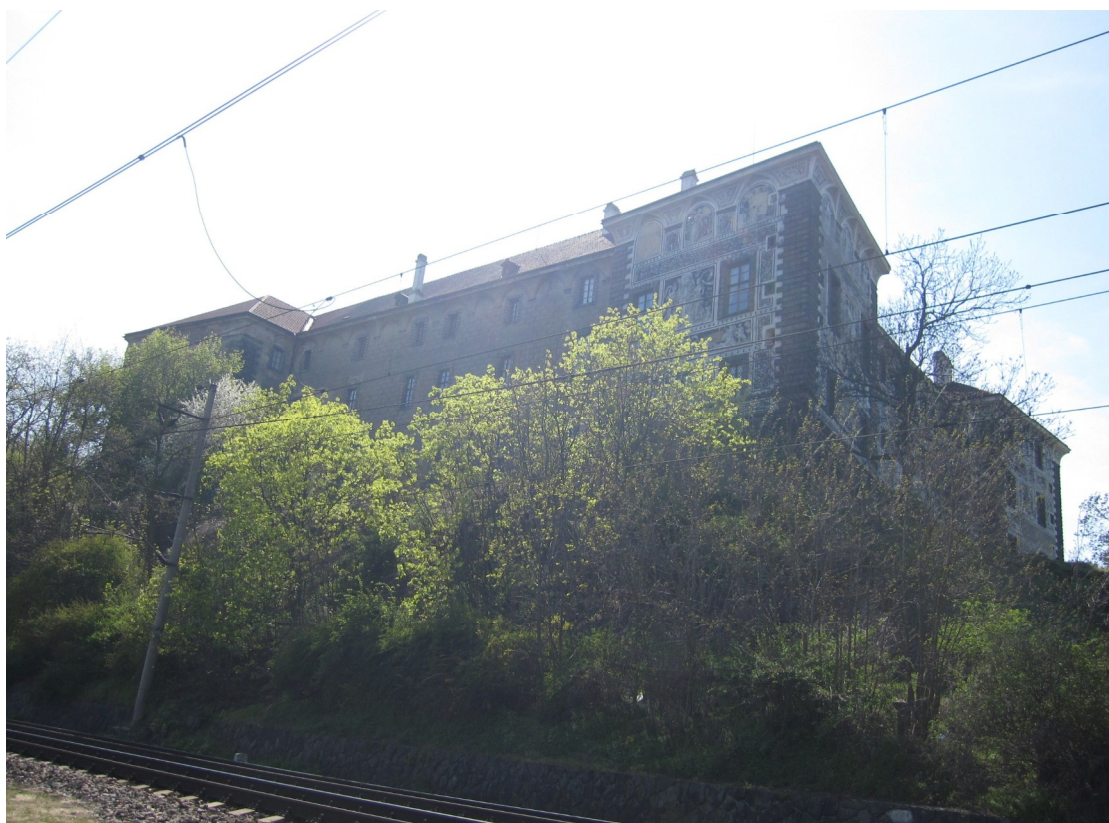
14. Nelahozeves, zámek, pohled od východu
