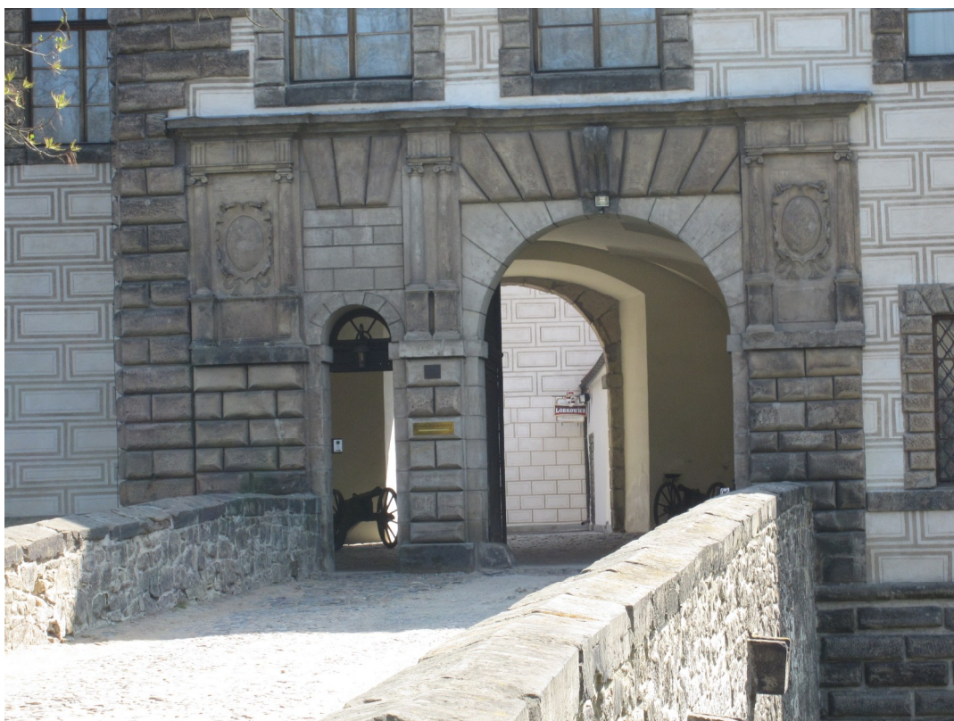
40. Nelahozeves, zámek, hlavní portál v jihozápadním bastionu
