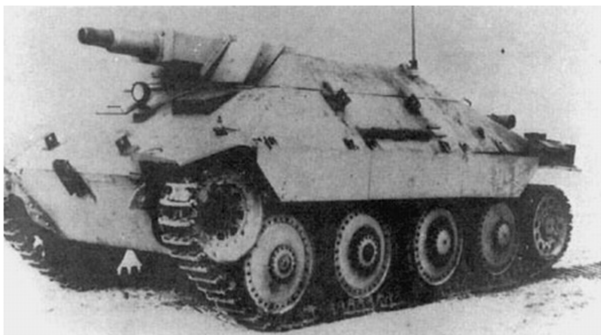
Aufklärungspanzer 38(t) se 75-ti milimetrovým kanonem KwK 37 L/24 (Zdroj: www. Panzernet. net )
