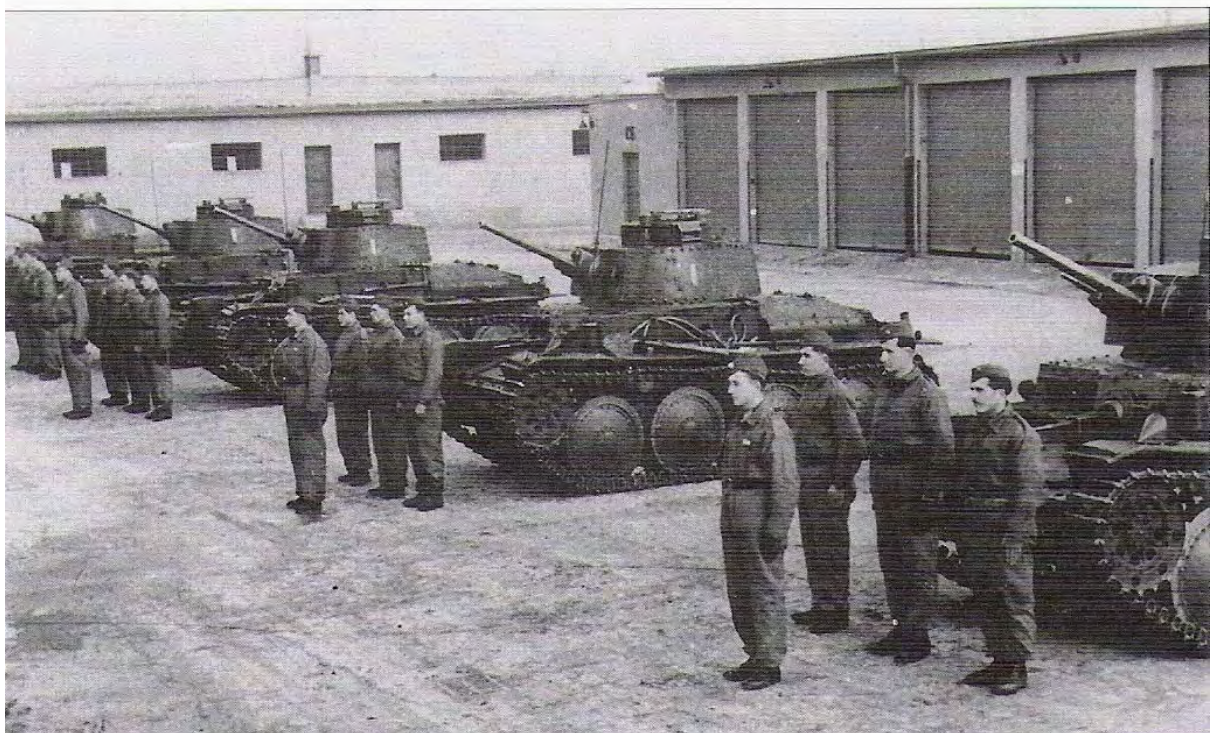
Tanky LT-38 a jejich osádky na nádvoří martinských kasáren. LT-38 se musel spokojit se dvěma muži ve věži, což trochu snižovalo jeho bojovou hodnotu, ale v malé věži prostě nebylo místo pro dalšího člena osádky.
