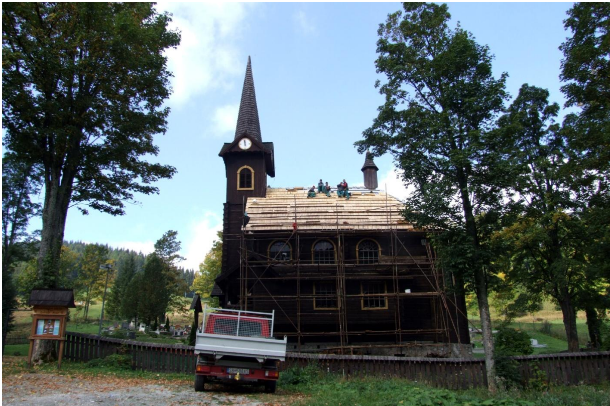
21. Kostol sv. Anny. Pohľad na západ. Oprava strechy z dňa 25.9.2009.
