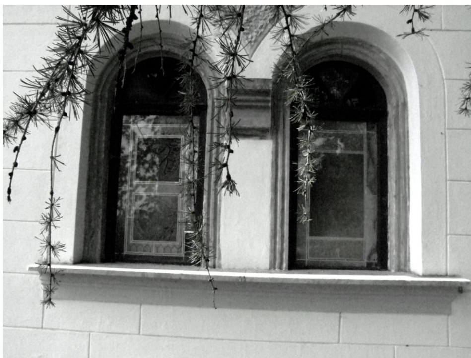
10. Tatranská Javorina. Hrobka rodiny Kégel. Južná fasáda.
