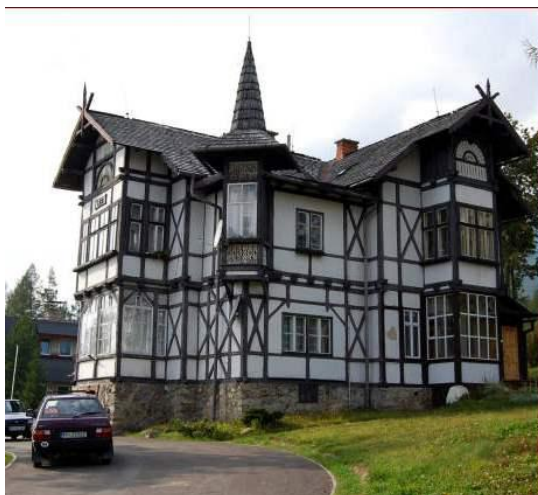
74. Starý Smokovec. Hrázdená konštrukcia omietnutá vápnom.
