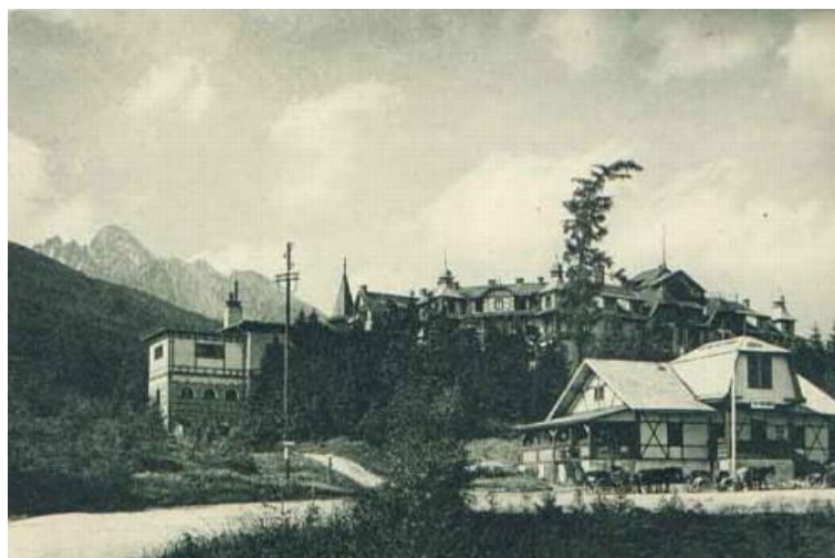
77. Starý Smokovec. Kombinovaná konštrukcia, murovaná alebo kamenná a hrázdená.
