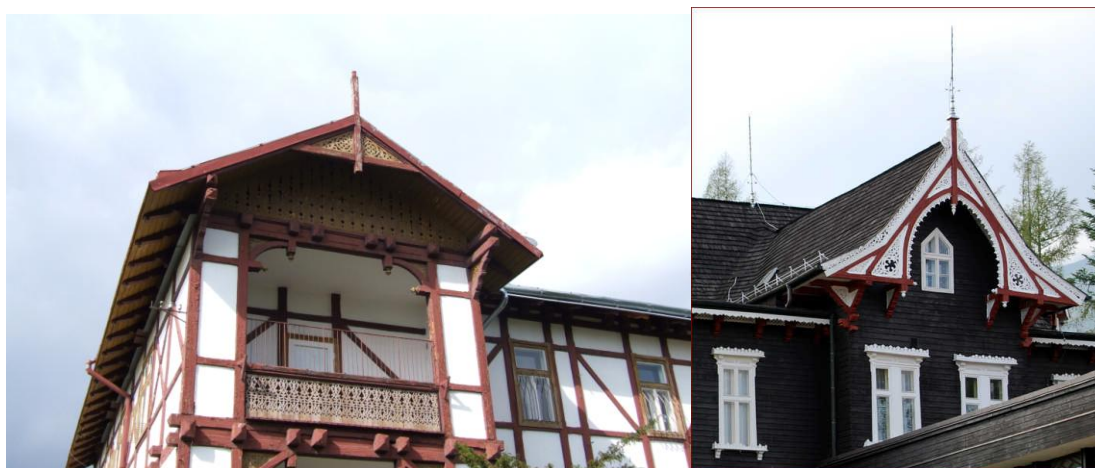
88. Dolný Smokovec. Detail na balkón sanatória, súčasný stav.
