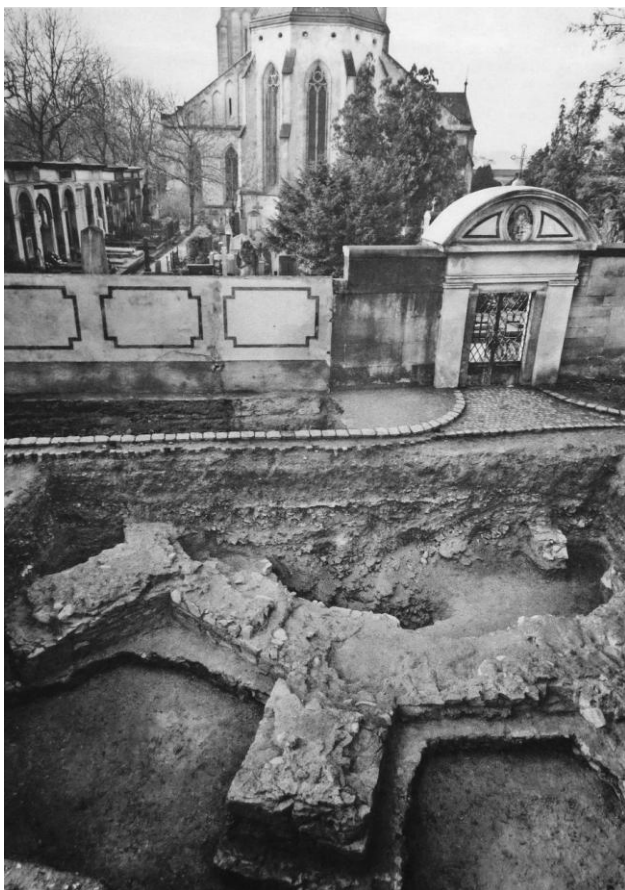
13. Vyšehrad, základy polygonálního závěru baziliky sv. Petra a Pavla, třicátá léta 14. století, pohled od severu
