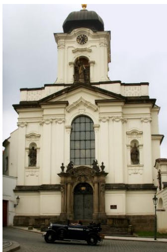
11. Kostel sv. Jana Nepomuckého v Praze na Hradčanech, K. I. Dientzenhofer, 1720–1729
