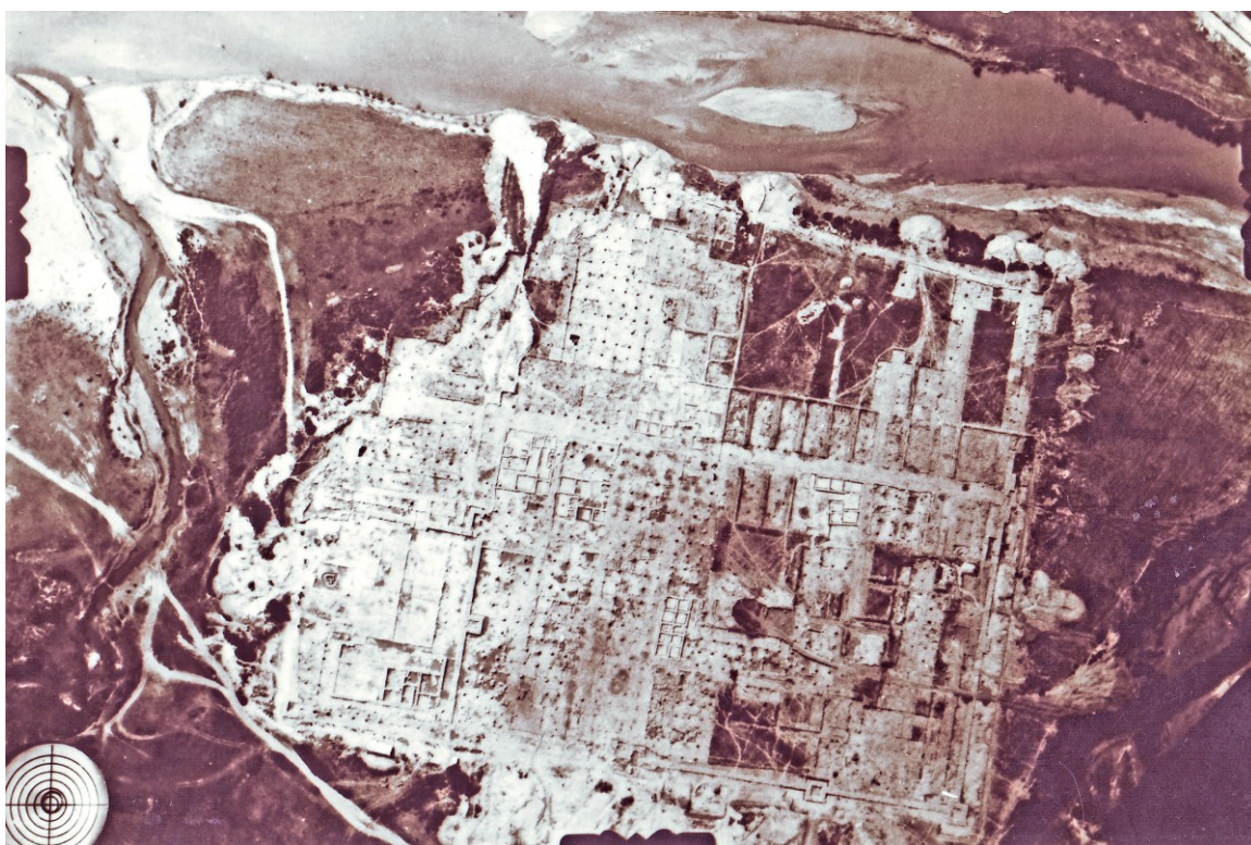
Obr. 43. Letecký pohled, Seuthopolis (Dimitrov 1984, 14, obr. 3).
