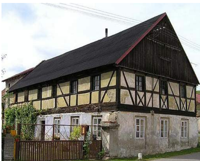
Obr. 56. Ukázka použití hrázděného zdiva (archiv autorky).
