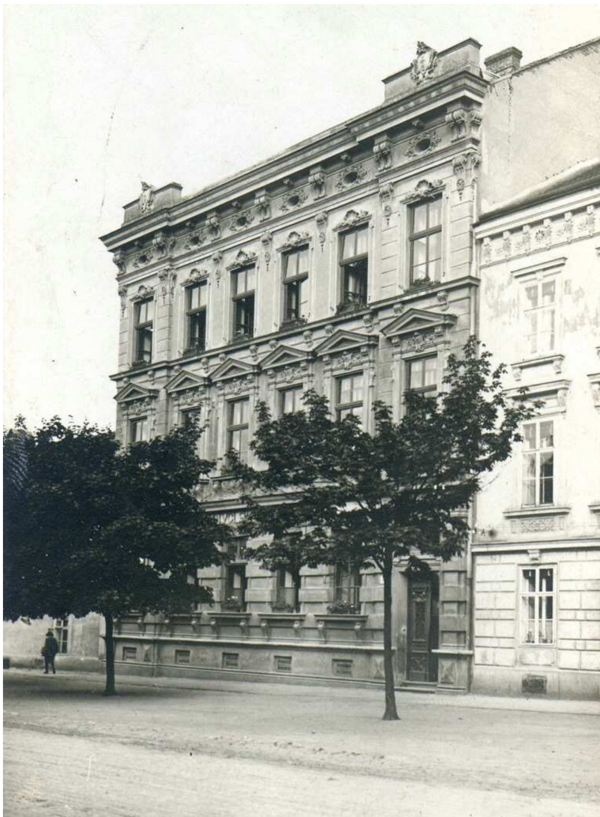
Obr. č. 1: Budova znojemské Vlasty na Haukově č. 8 (dnes ulice J. Palacha) v roce 1923, autor Vyhnánek. (F II/ 1119/11)
