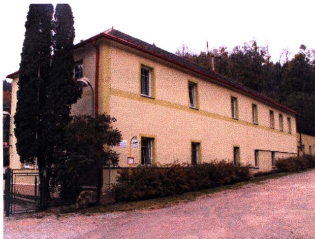
Foto č. 4: Hlavní budova
