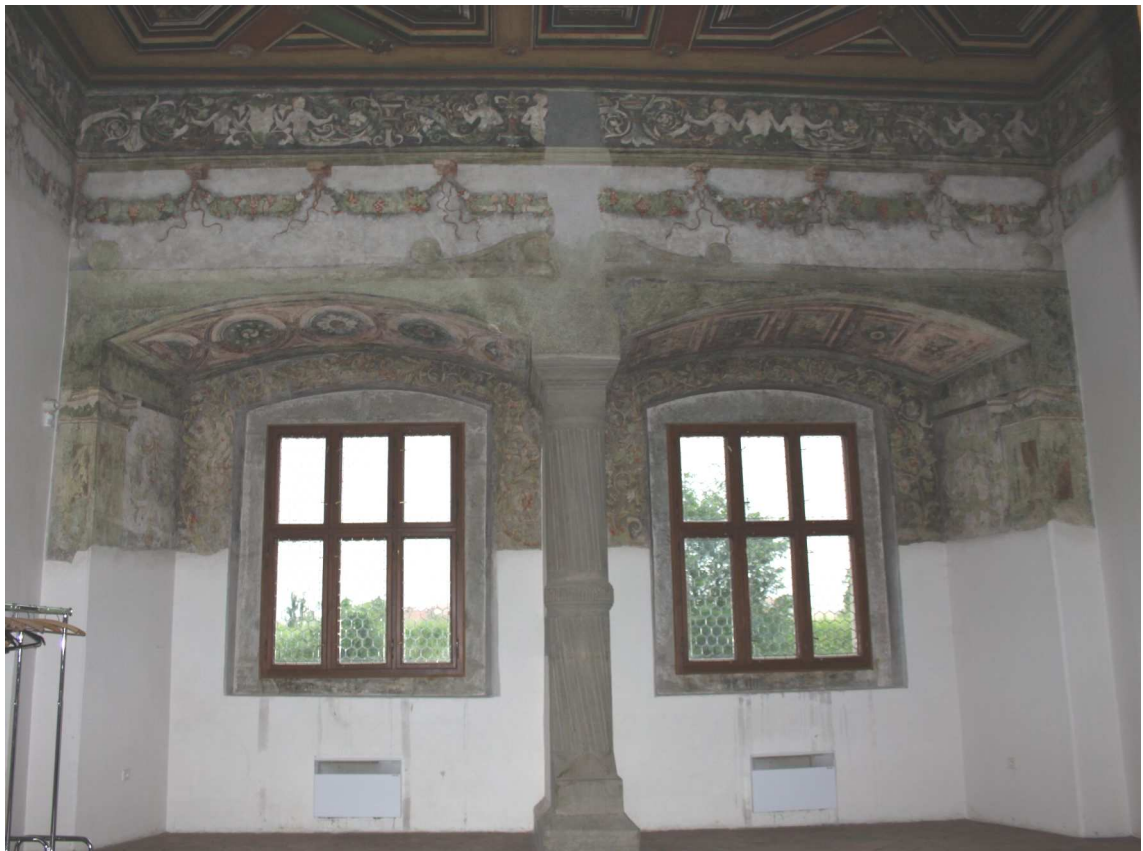
30. Sloupový sál, 1. polovina 30. let 16. století, východní stěna
