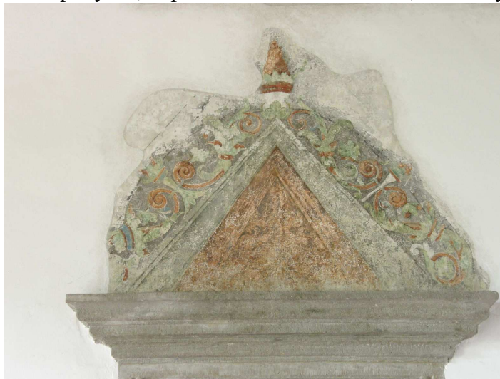
32. Sloupový sál, 1. polovina 30. let 16. století, nástavec portálu, jižní stěna
