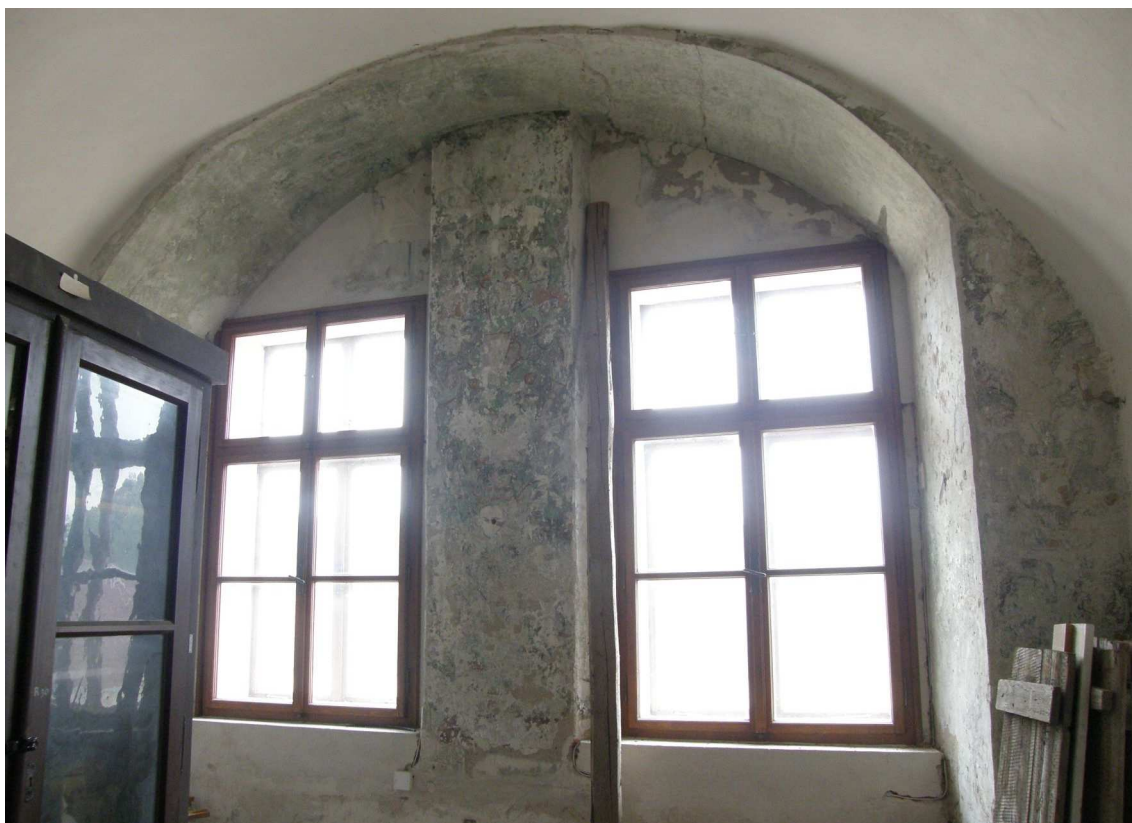
45. Depozitář nábytku, 1. polovina 30. let 16.století, okenní nika, severní křídlo, S stěna
