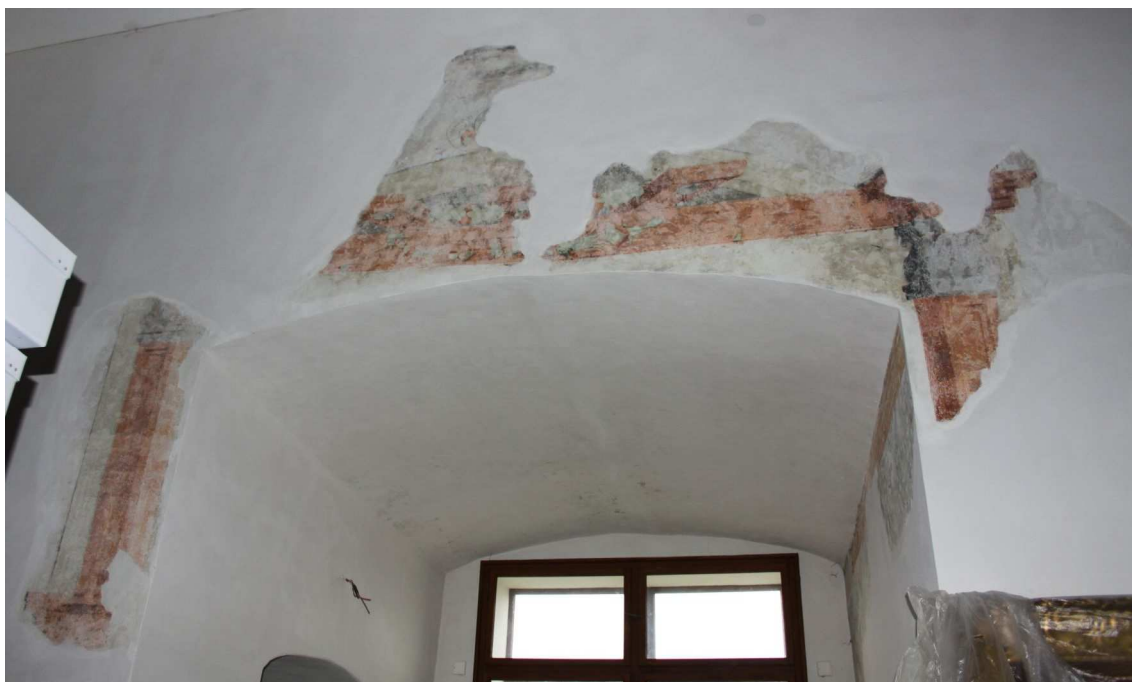
48. Depozitář, 1. polovina 30. let 16.století, SV nároží, severní stěna
