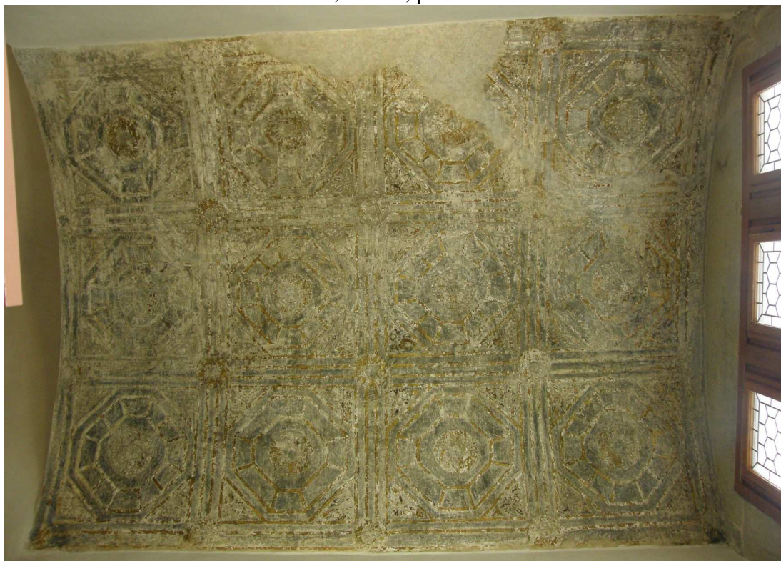
2. Klenba záklenku gotického sálu, 20. léta 16.století, přízemí severního křídla
