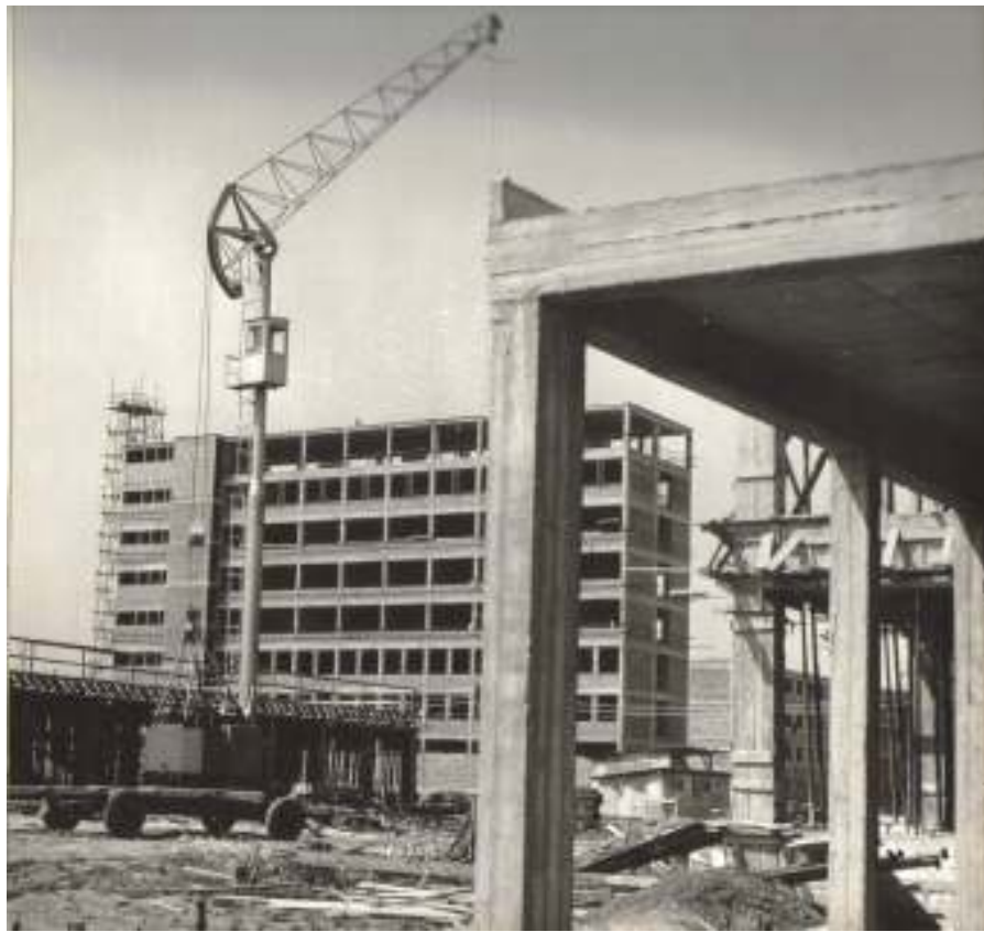
29. Průběh stavby areálu. Pohled na rektorát
