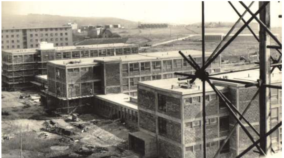
30. Průběh stavby areálu. Pohled na Mechanizační (dnes Technickou) fakultu
