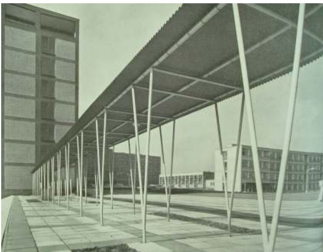
32. Původní pergola, která spojovala budovu rektorátu s aulou
