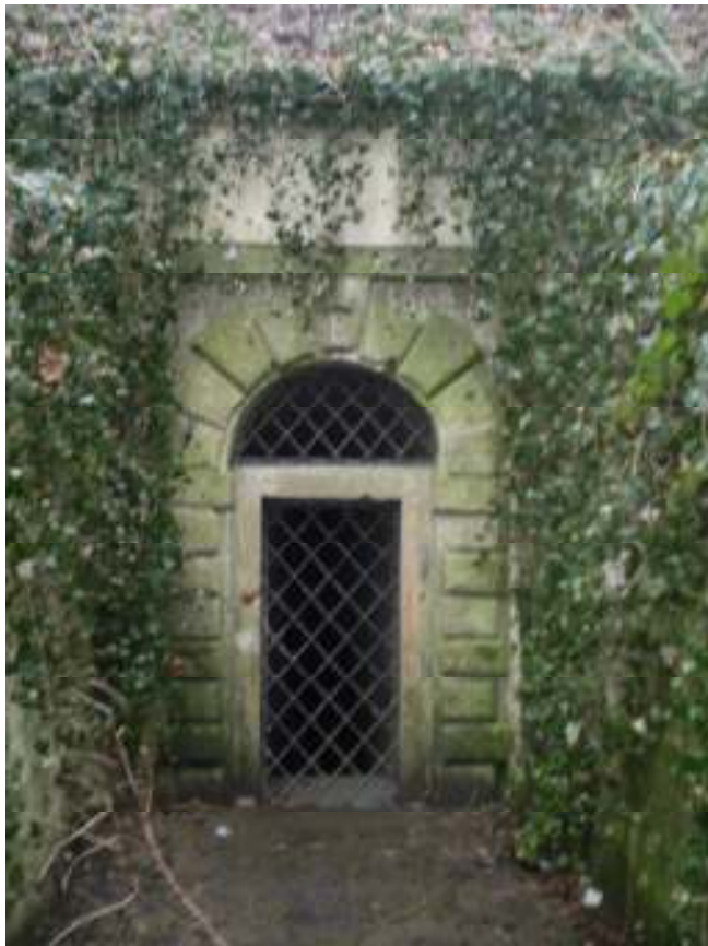
25. Portál Rudolfovy štoly
