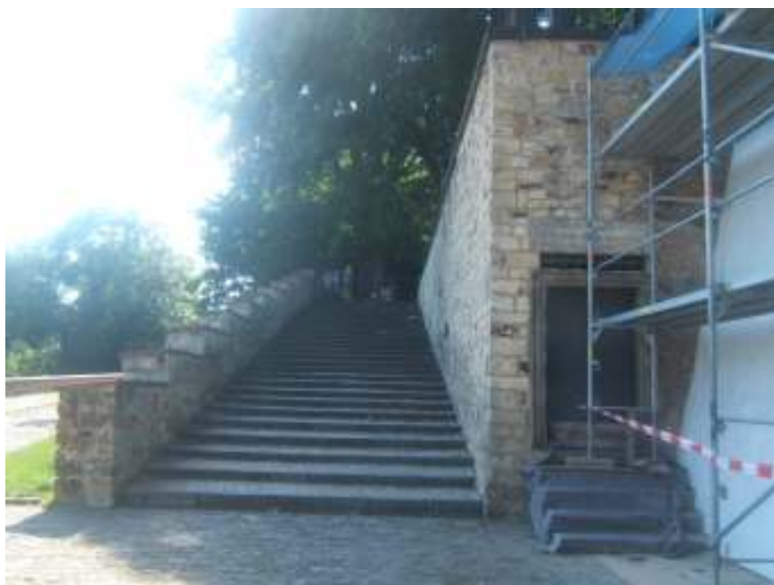
18. Dnešní stav schodiště vedoucí na dolní terasu pod Královským letohrádkem
