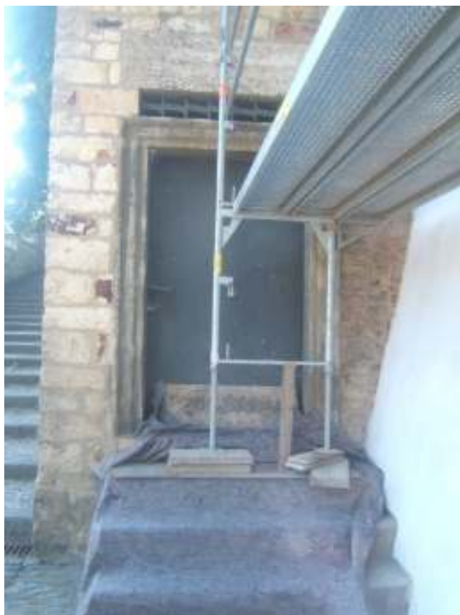
17. Kamenný portál v místech vyústění dvouramenného schodiště
