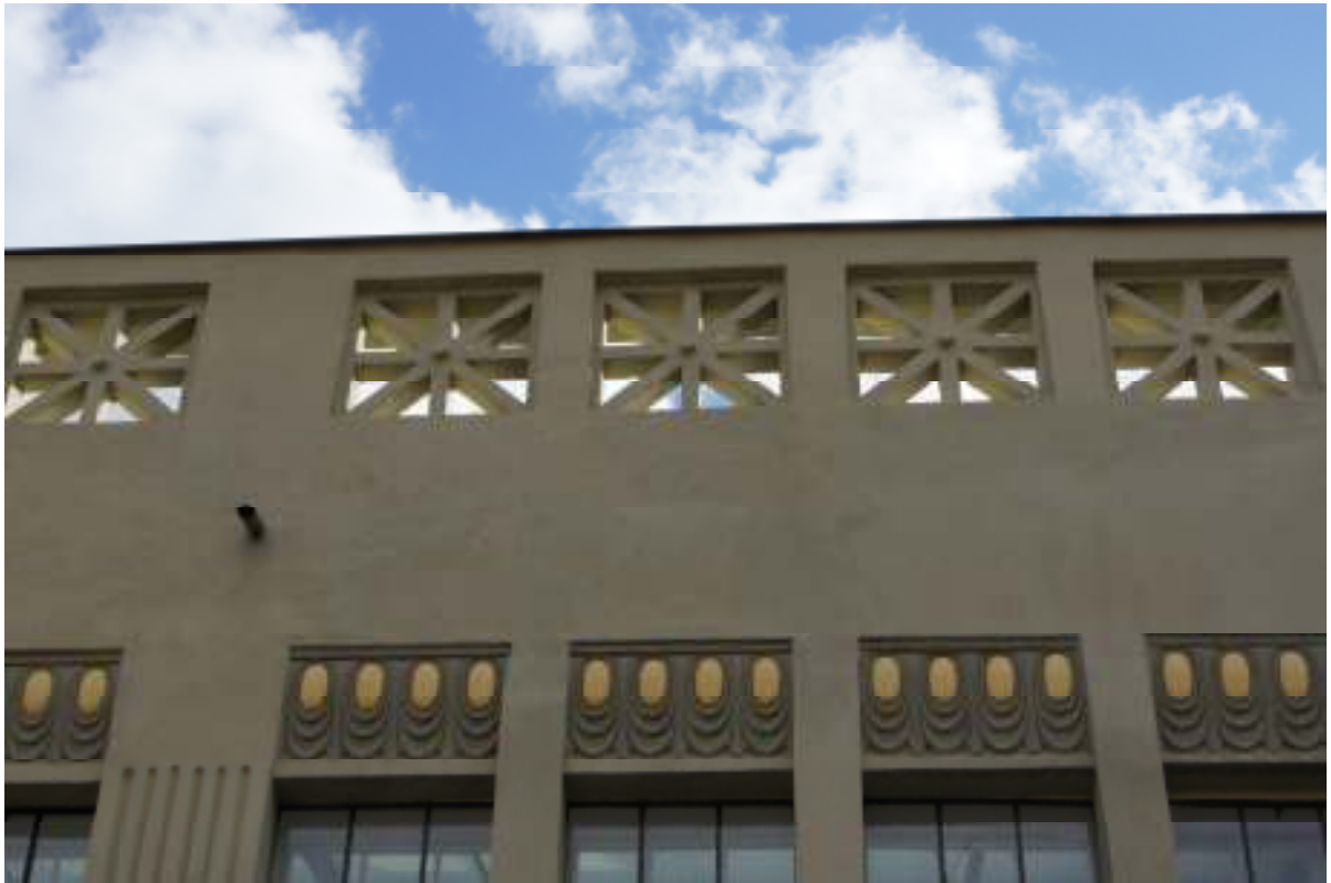
16. Motiv vejcovce vedený nad okny do ateliéru, stav po rekonstrukci.
