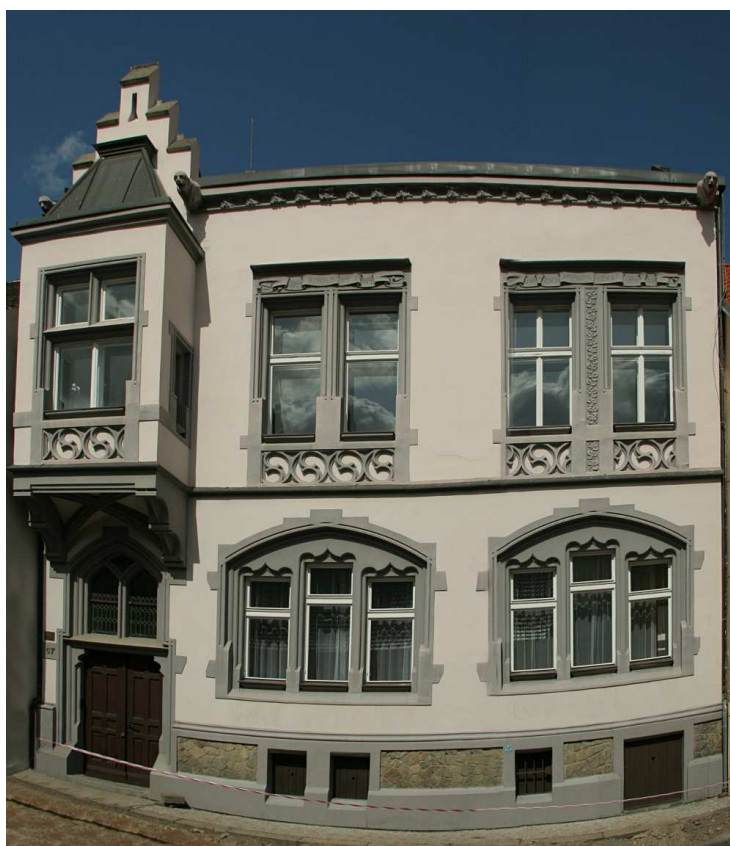
24. Kamil Hilbert: Hessův dům, 1898, Louny, Hilbertova ulice 67, průčelí
