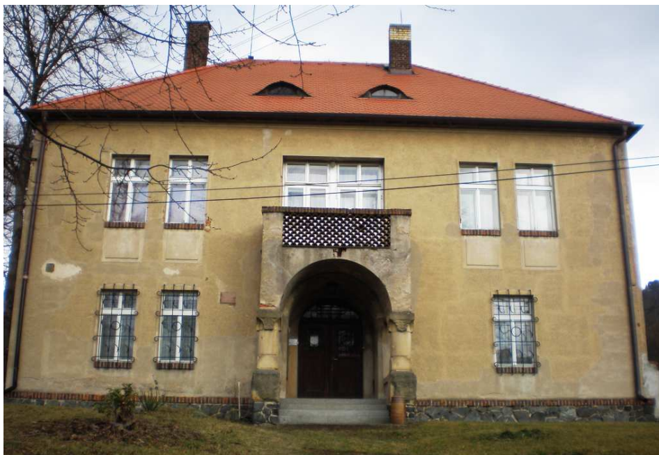
51. Kamil Hilbert: Fara, 1911–1912, Štěchovice, pohled na západní průčelí
