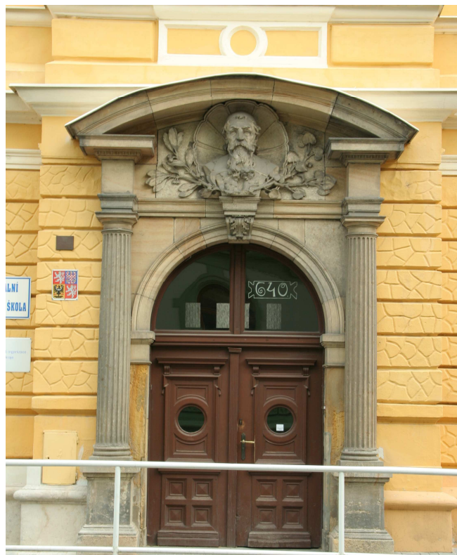
14. Kamil Hilbert: Zvláštní škola, 1897, Louny, Poděbradova ulice 640; a) pohled na nároží, b) vstupní portál
