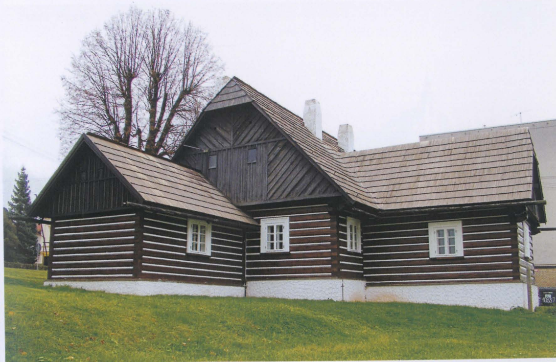
52. Současný stav budovy bývalé staropacké školy z roku 1799, v letech 1803–1846 působiště Jiřího J. B. Hartla (foto L. Tyllner 2004); 53. Přístavek k budově bývalé staropacké školy, vystavěný nákladem Jiřího J. B. Hartla roku 1824 (foto L. Tyllner 2004)
