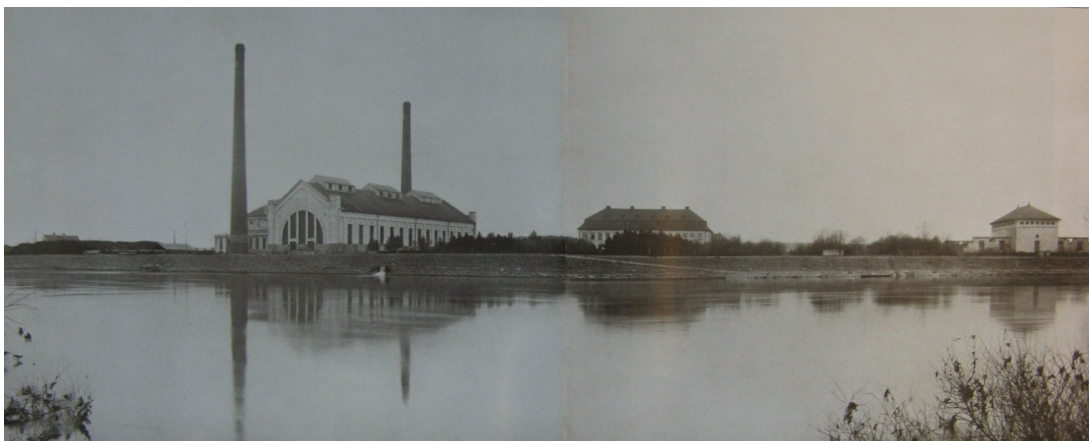
Pohled na káranou vodárnu. Opatrný, Vodárna, str. 25-26.
