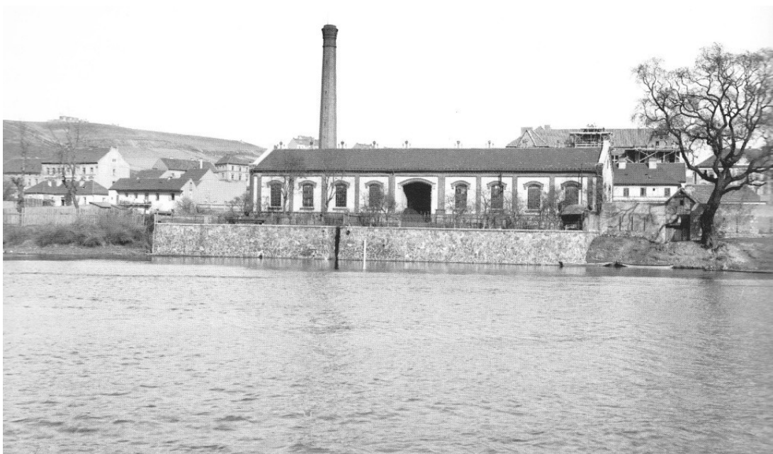
Původní vodárny města Prahy v Podolí, Jásek a kol., Podolská vodárna, str. 16.
