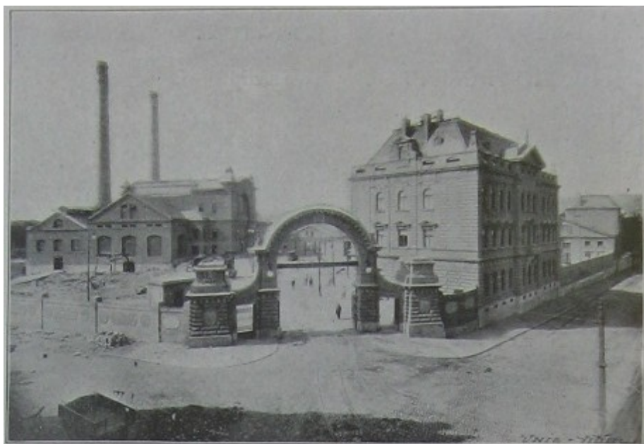
Holešovická elektrárna, Ústřední el. stanice, str. 47.
