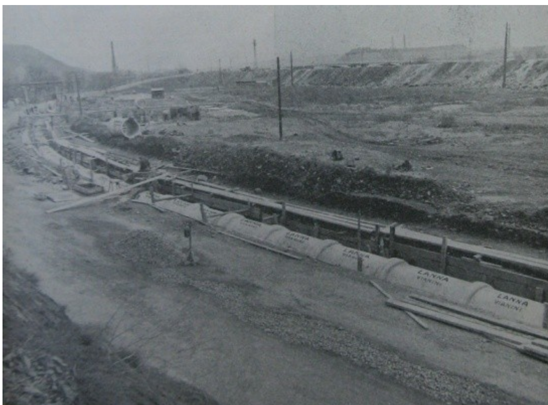
Pokládání sběrače kmenové stoky E ve 30. letech 20. stol., Holinka, Stavba kmenové stoky, str. 515.
