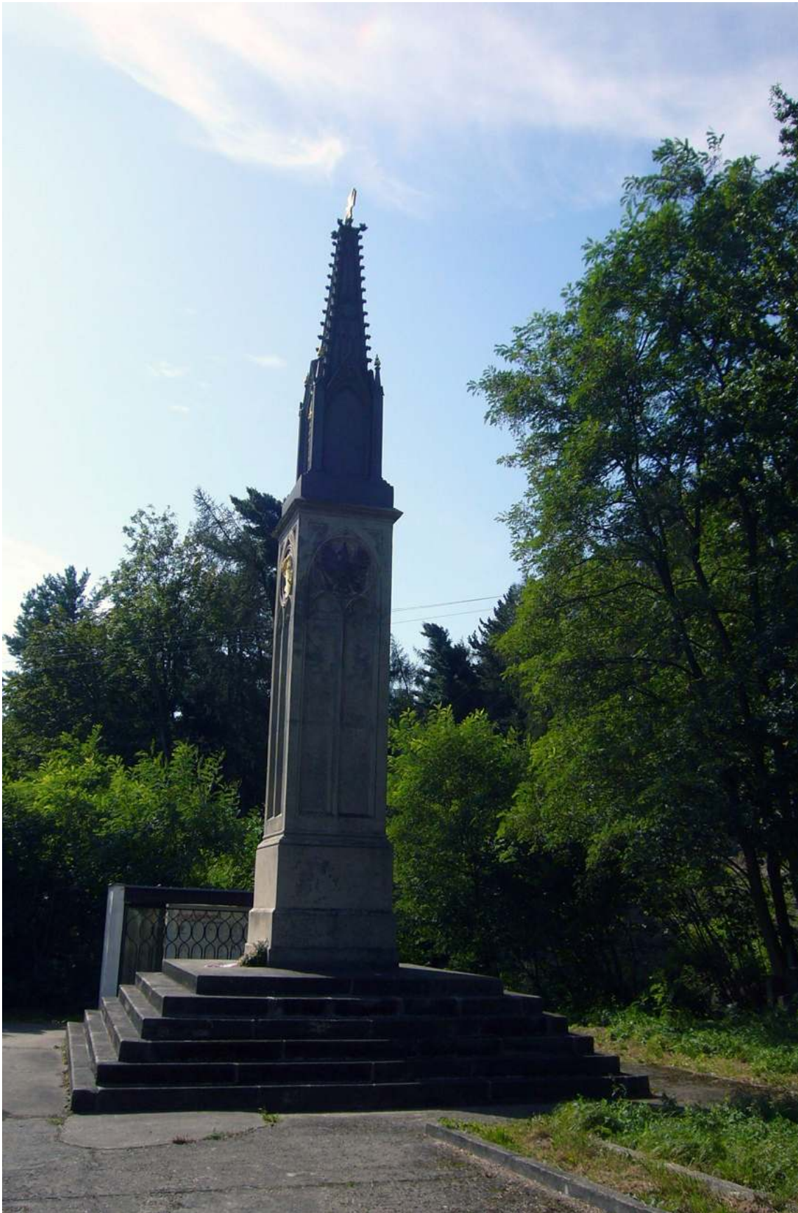
Pruský pomník v dnešní podobě poté, co byl vyzvednut na betonový sokl (archiv autora).
