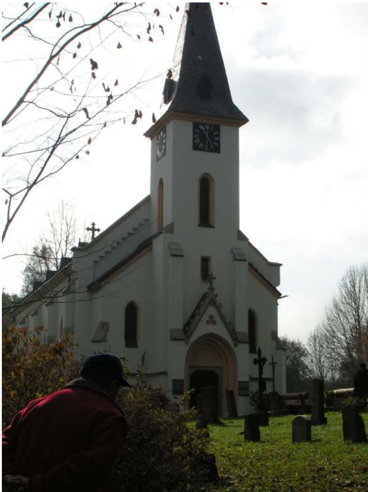
Obr. 28, Zvonková, kostel sv. Jana Nepomuckého, pohled na západní průčelí
