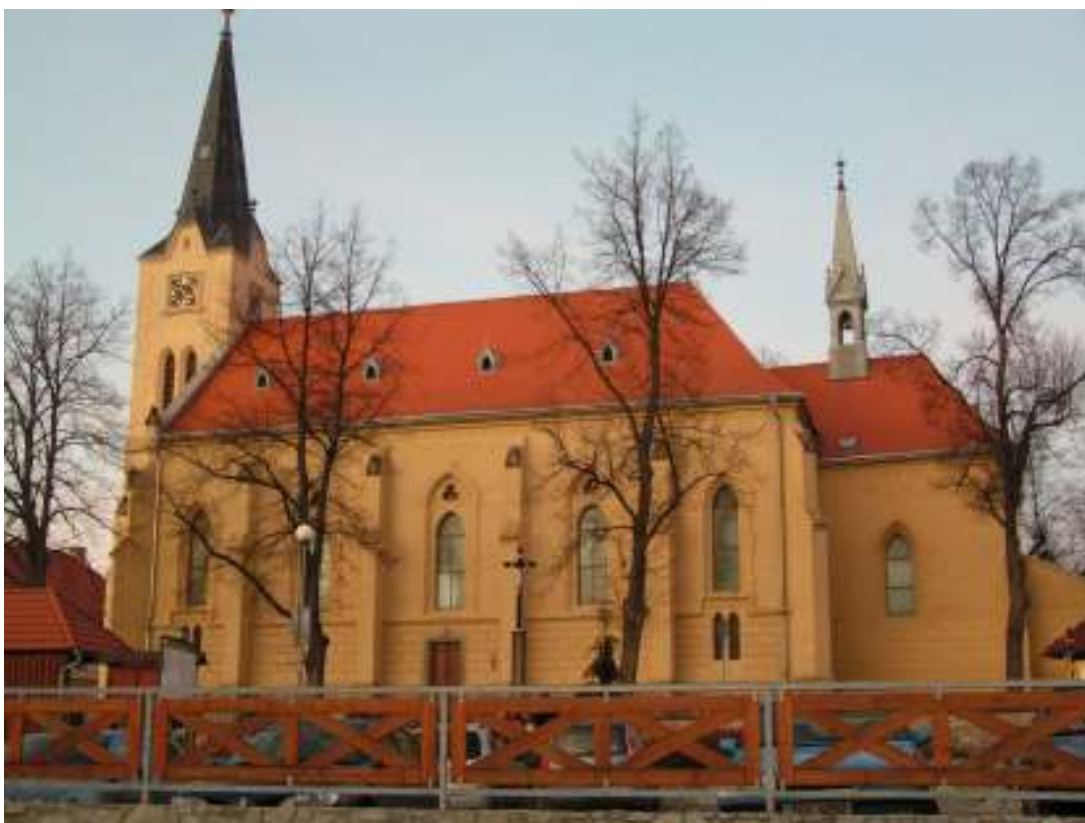
Obr. 16, Křemže, kostel Archanděla Michaela, pohled na kostel od jihu
