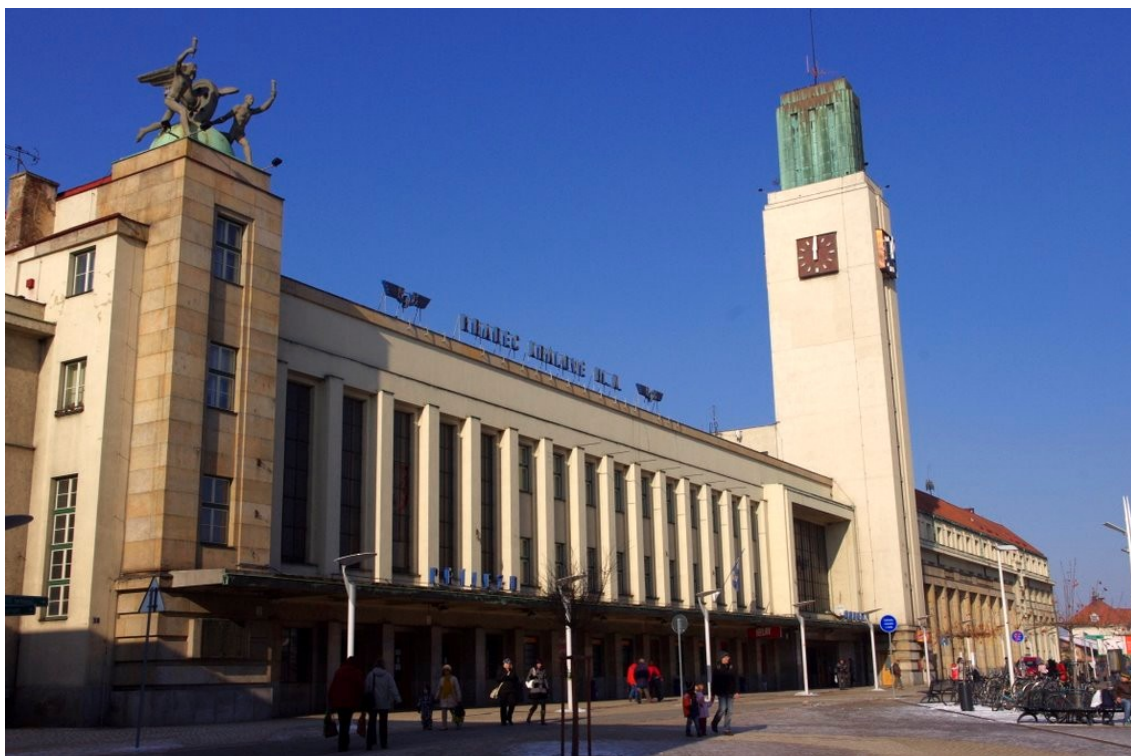
Obr. 52 – Budova hl. nádraží v Hradci Králové. Leden 2011. Budova byla postavena v letech 1929-1935 dle projektu Jana Rejchla. Na ose hl. průčelí vystupuje 46 m vysoká předsazená hranolová věž s hodinami, v jejímž vrcholu byl nainstalován vodojem pro zásobování stanice vodou. Sousoší od Josefa Škody symbolizuje přínos železnice rozvoji lidstva. (FLEK, 2008)
