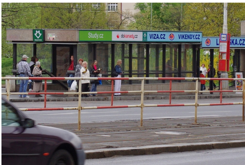
Obr. 60 – Vstupní prostor stanice Dejvická, Praha, duben, 2011.
