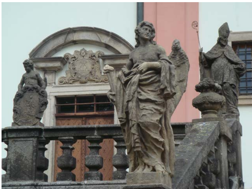
5. Anděl s pochodní na balustrádě jižního schodiště
