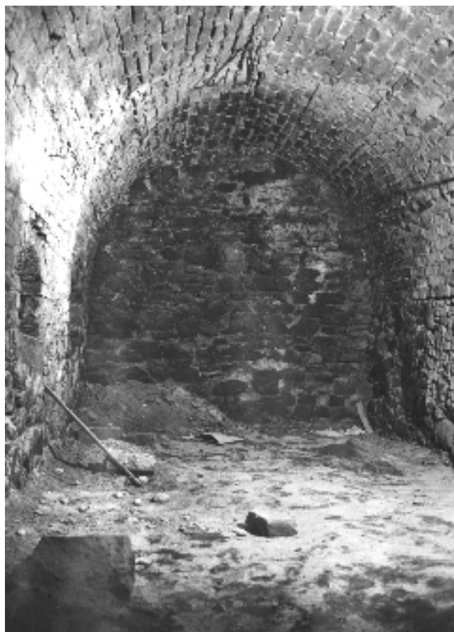
Klenutý prostor uvnitř objektu – patrné kamenné i cihlové zdivo. Archiv Muzea Podblanicka
