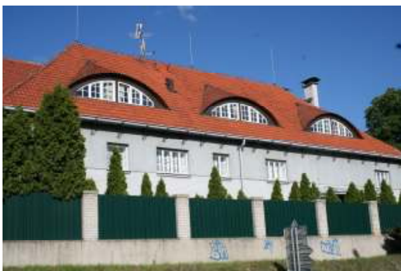
63. Kladno, současný stav dnešního Penzionu Hoffmann, 1902-1903, západní strana
