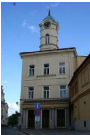
10. Kladno, původní budova radnice, podoba z roku 1910, pohled ze severu
