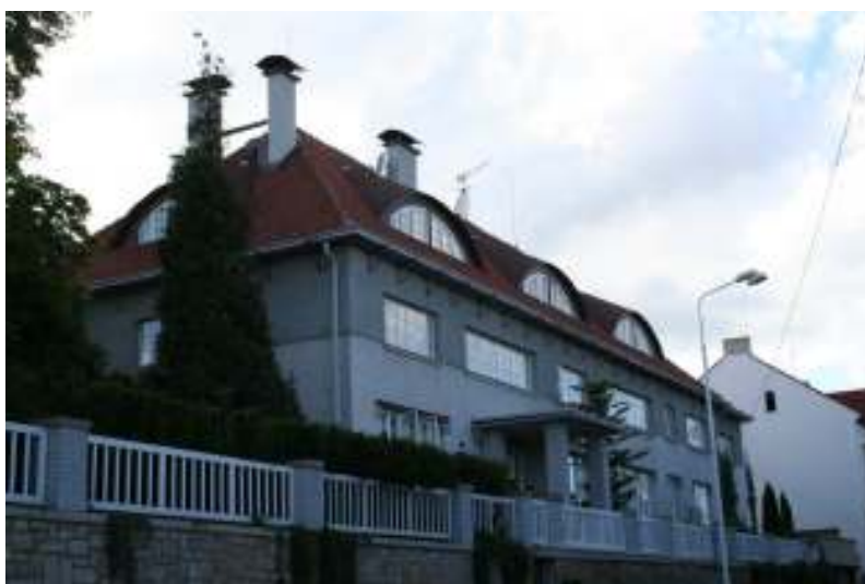
59. Kladno, současný stav Domu Hostí, 1902-1903, jihovýchodní pohled
