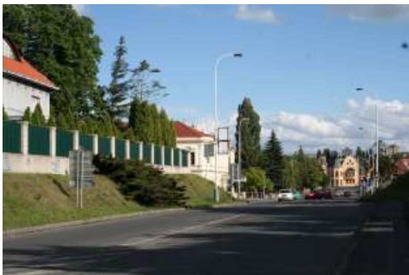
65. Kladno, vlevo část Penzionu Hoffmann a vpravo v dálce secesní budova bývalého okresního domu, počátek 20. století, severozápadní pohled
