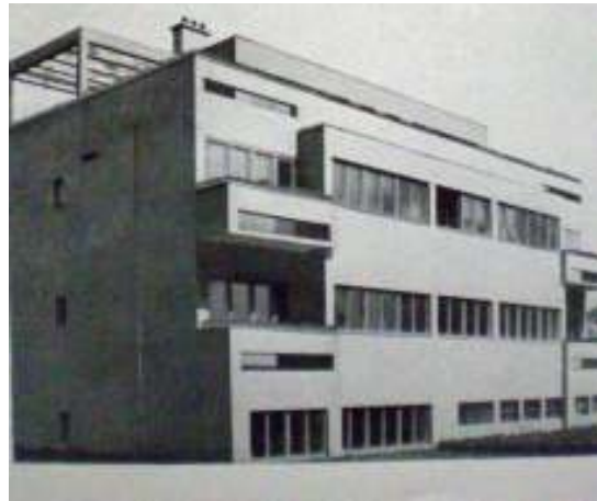
4. Josef Havlíček: obytný dům Svazu Čs. Díla, 1928. Brno
