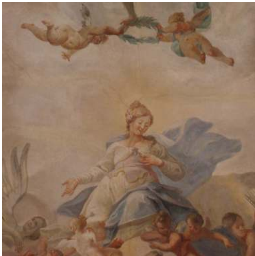
96 Trhliny v klenbě presbytáře. Foto: Petr Hobza
