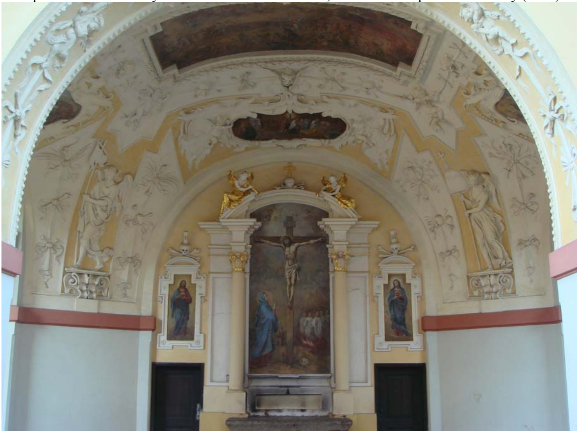
8. Dušičková kaple v západní části ambitu situovaná pod zvonící (1687)
