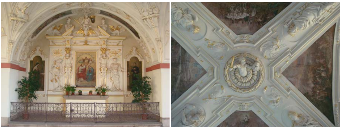
7. Kaple korunování Panny Marie v severní části ambitu, oltářní stěna a pohled do klenby (1674)
