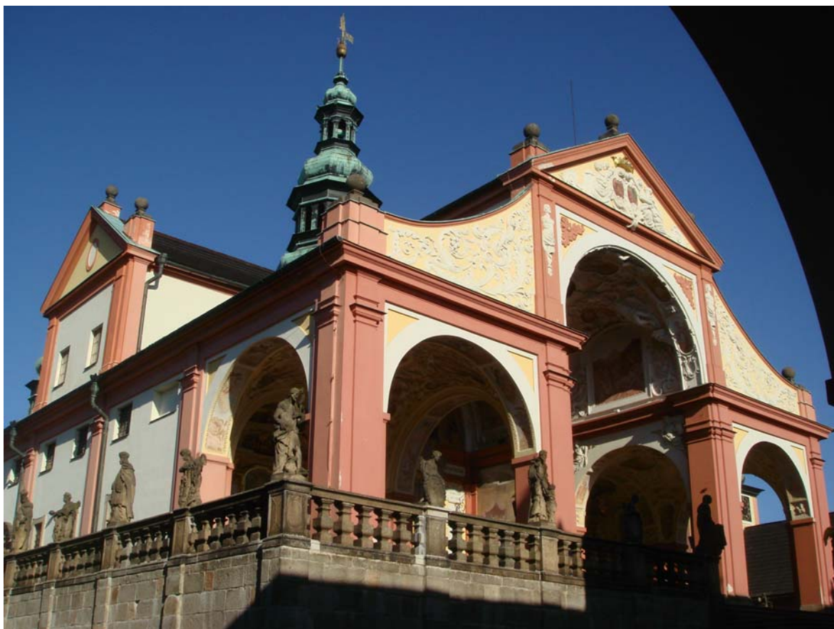
1. Svatá Hora, svatyně na vyvýšené terase s otevřenou východní lodžii (1660–1673)
