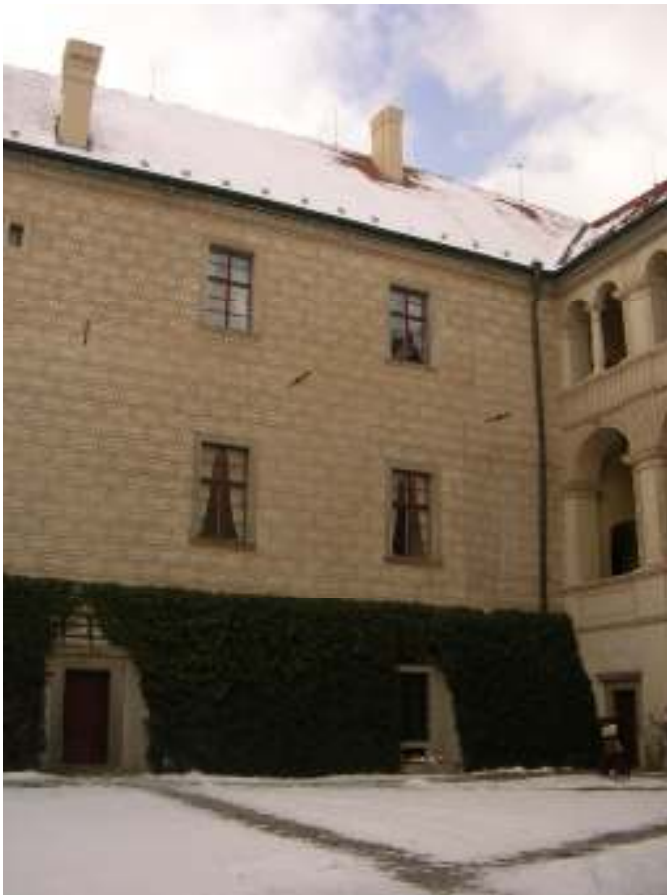
20. Nádvoří stěna západního křídla
