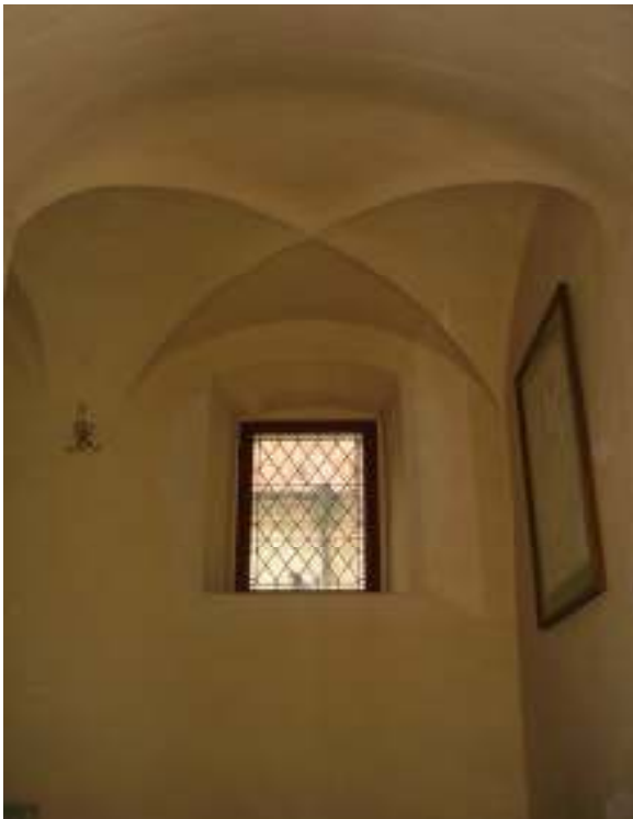
9. Klenba v mezipatře schodišťové věže
