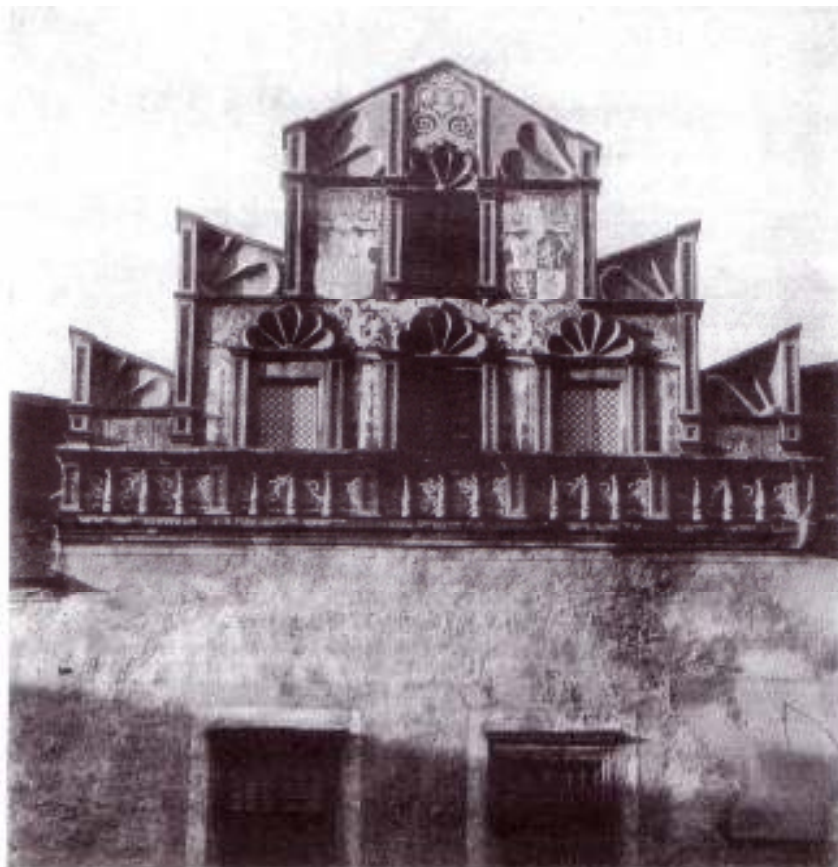
26. Štít východního křídla zámku v Telči, sgrafitová výzdoba
