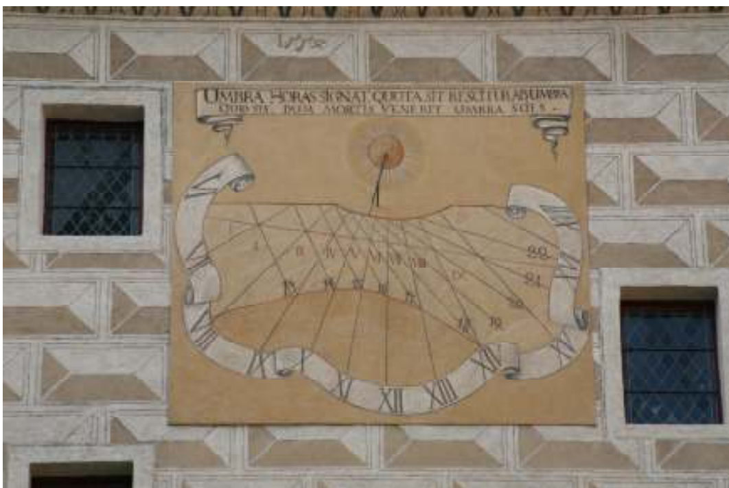
23. Sluneční hodiny na schodišťové věži. Letopočet 1554 umístěný ve fasetě valbově jehlancové boky nad slunečními hodinami
