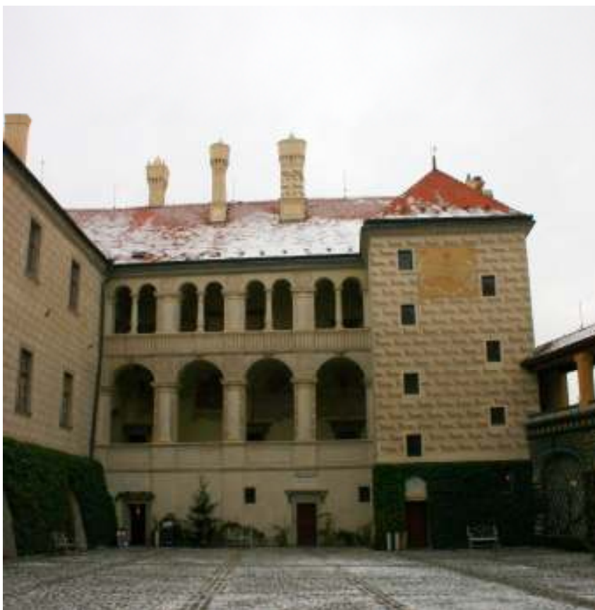
4. Severní křídlo mělnického zámku – arkády, schodišťová věž
