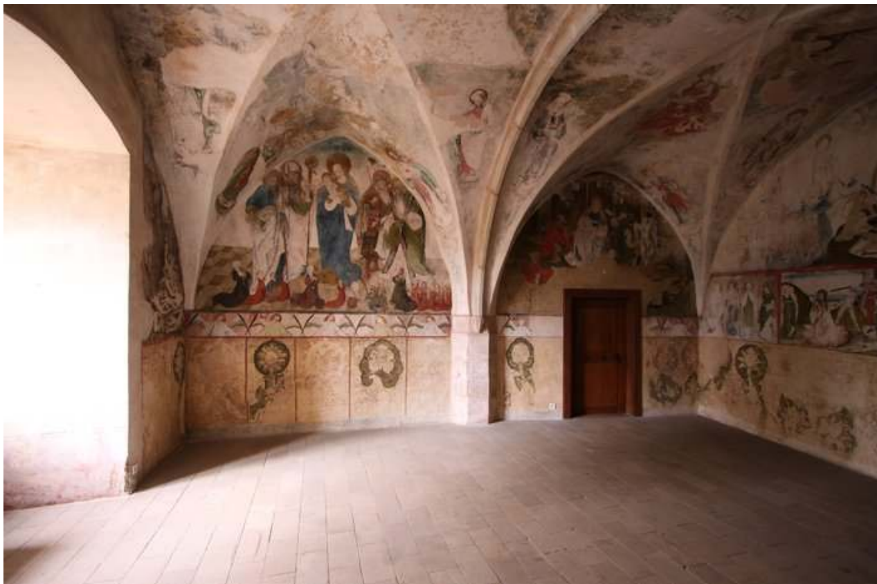
Obrázek 3. Žirovnice, kaple, pohled na jihozápadní stěnu
