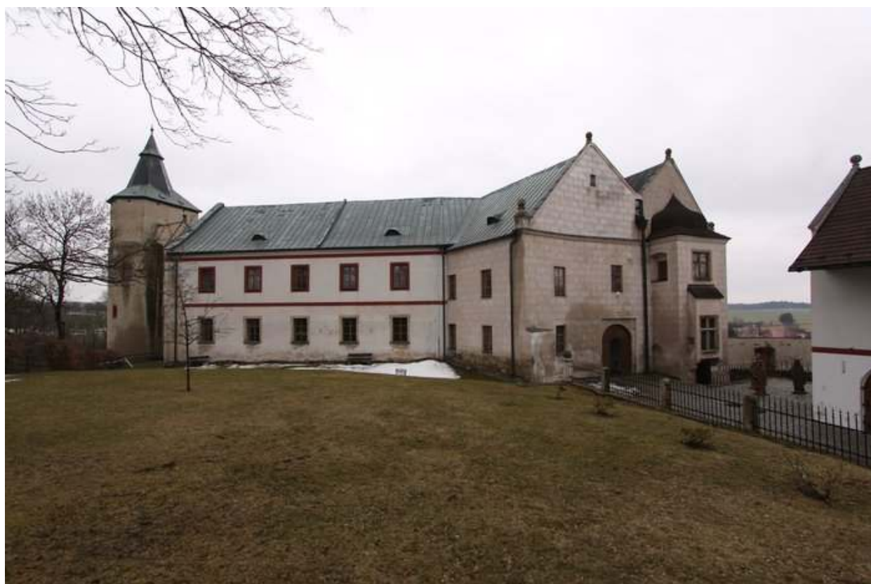
Obrázek 2. zámek Žirovnice, pohled od východu.
